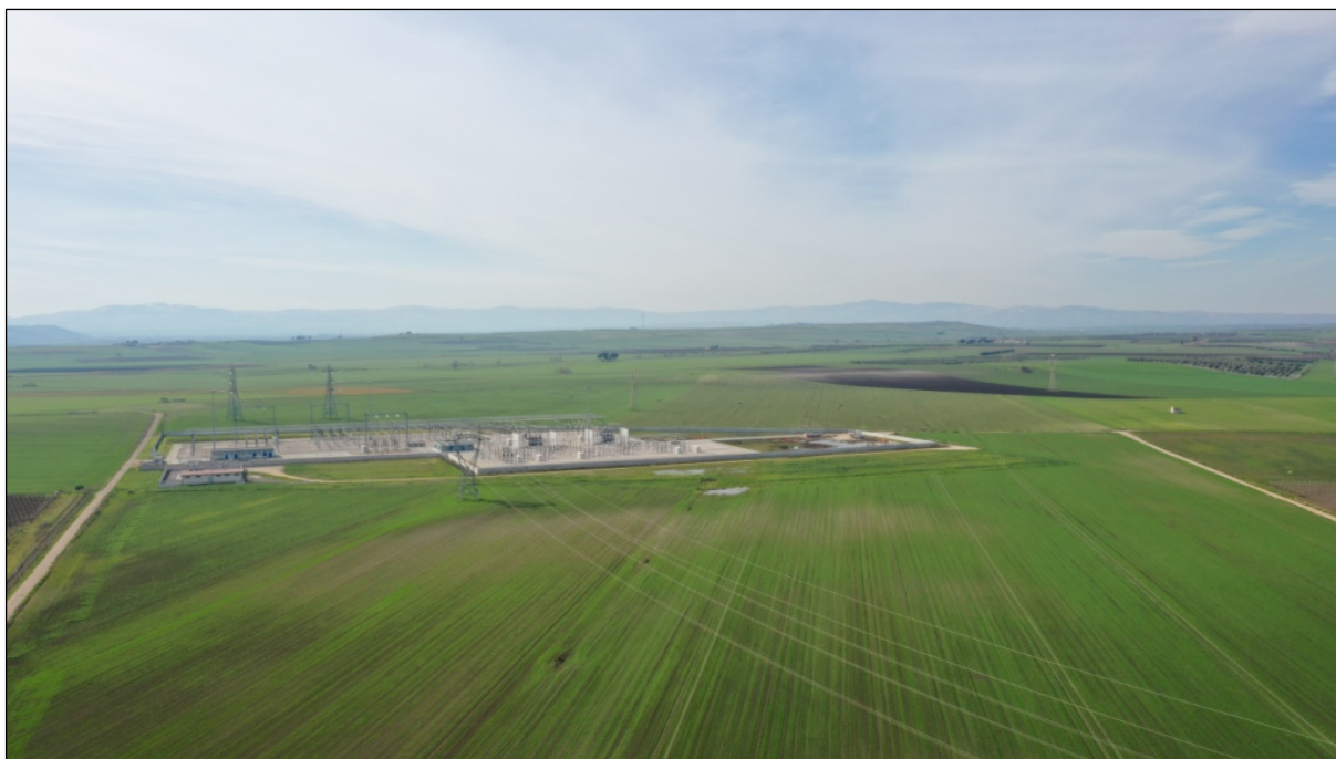
Figura 3 – Vista aerea della stazione elettrica Terna “San Severo”.
