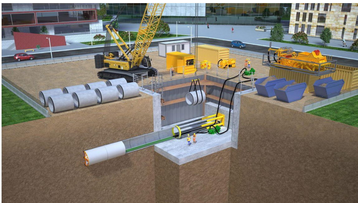
Figura 2-20 Rappresentazione in dettaglio dell'attività lavorativa
