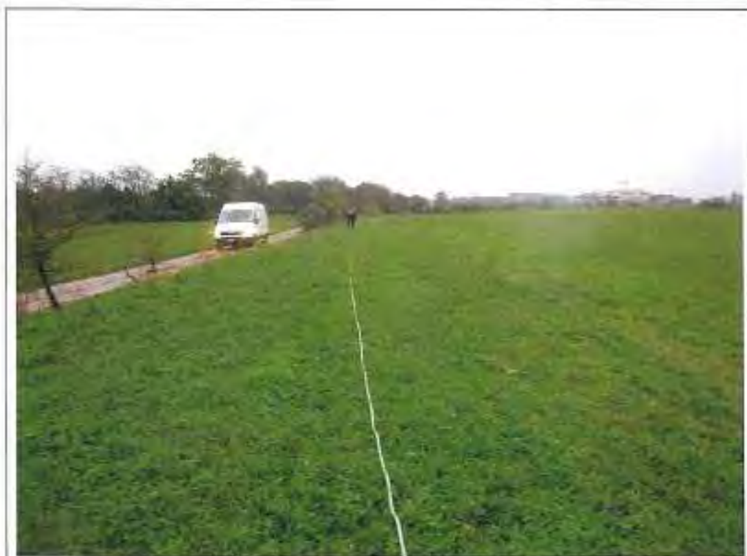
Esecuzione profilo sismico a rifrazione 4-4'
