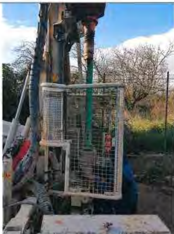
Esecuzione prova SPT (S3)
