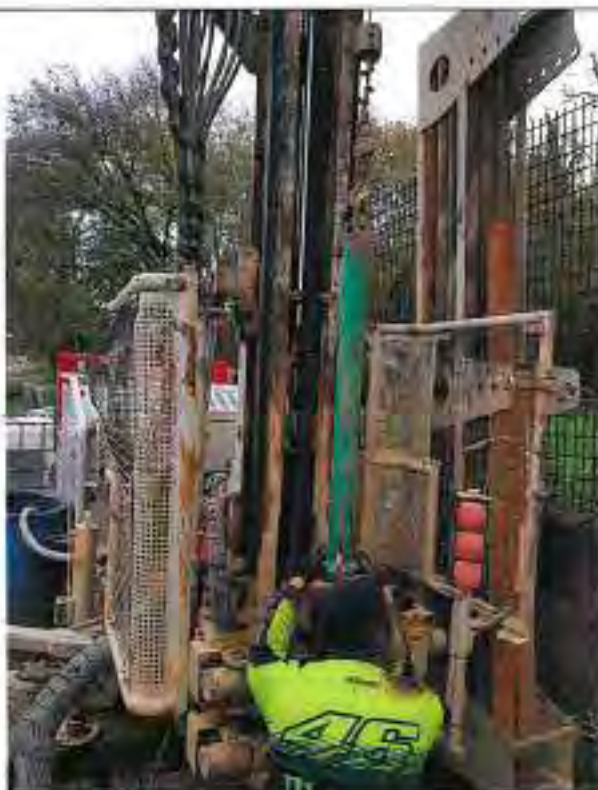
Esecuzione prova SPT (S4)
