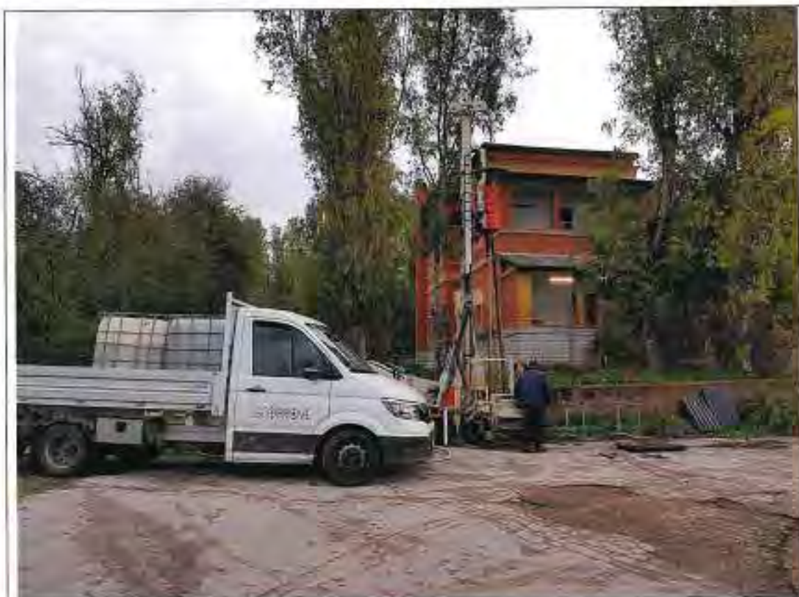
Postazione ed Esecuzione sondaggio S4
