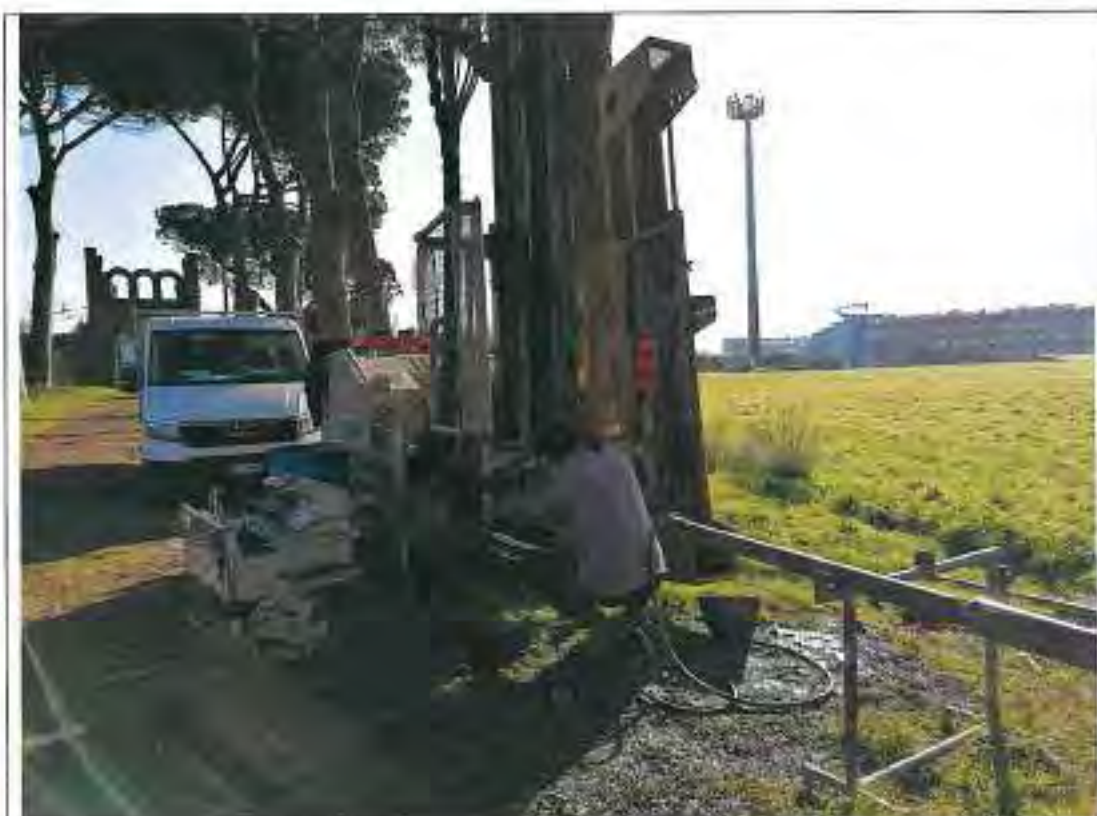
Esecuzione prova SPT
