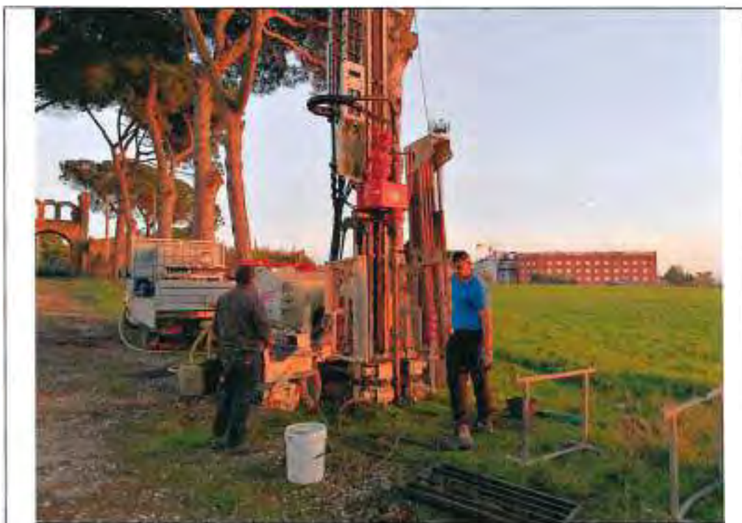
Esecuzione sondaggio S1
