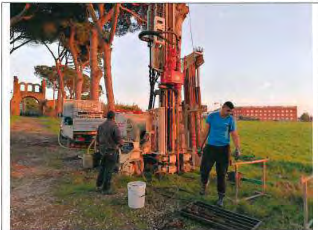
Postazione ed Esecuzione sondaggio S1
