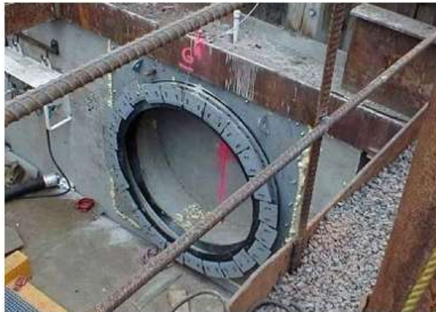
Figura 15.3 – Immagine della guarnizione di ingresso (da Herreknecht website)
