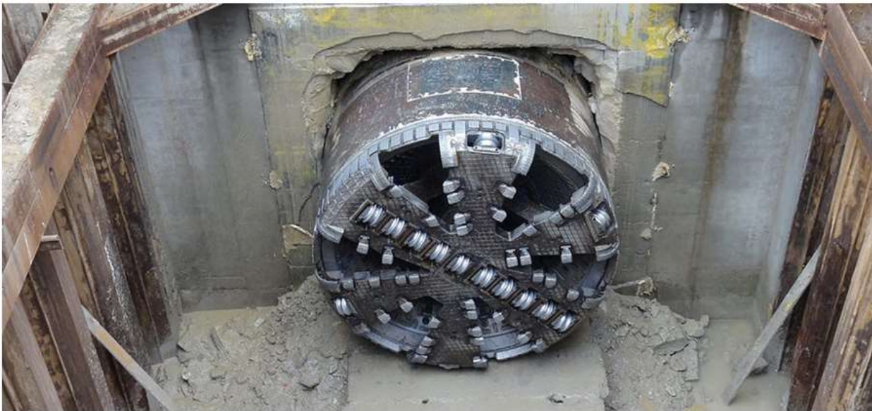
Figura 15.11 – Esempio di testa fresante per scavo di materiali misti.
