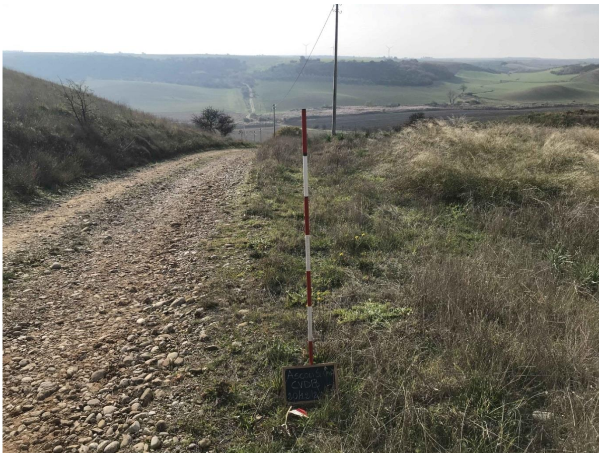
Fig. 18 Foto strada interpoderale interna all'area protetta (Cavidotto MT)
