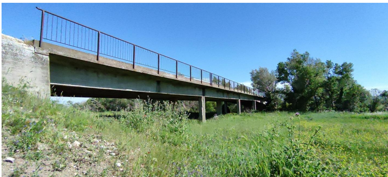
Fig. 22 Foto Ponte sul Fiume Ofanto (Cavidotto AT)
