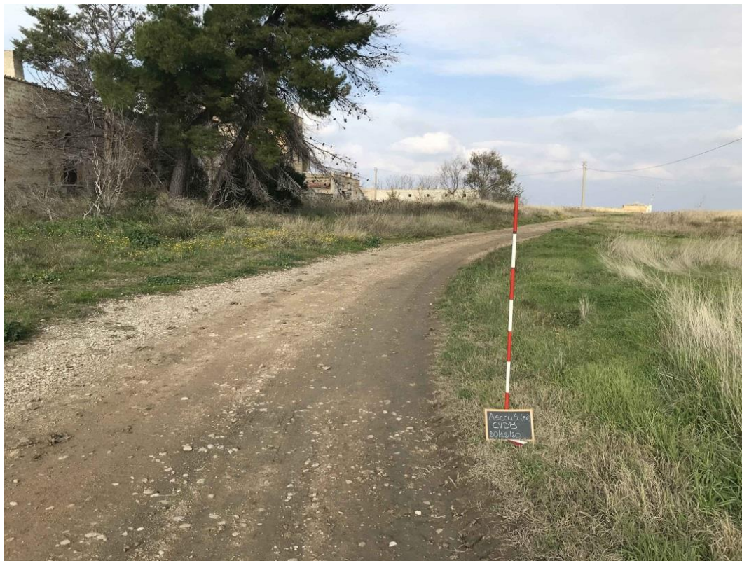
Fig. 17 Foto strada interpoderale interna all'area protetta (Cavidotto MT)
