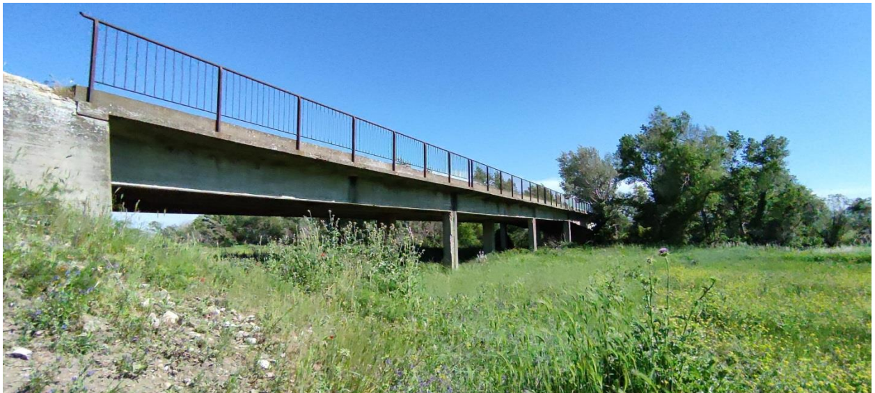
Fig. 22 Foto Ponte sul Fiume Ofanto (Cavidotto AT)
