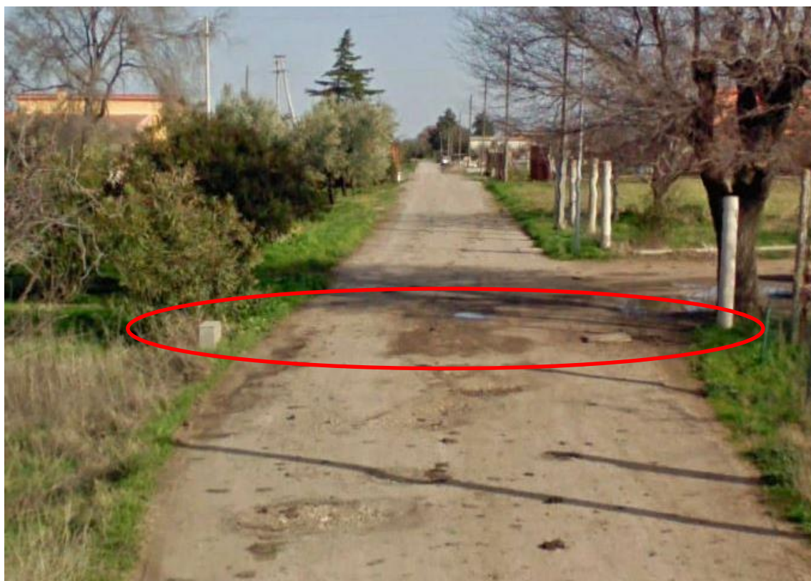
Fig. 34 Foto interferenza condotta idrica n 5
