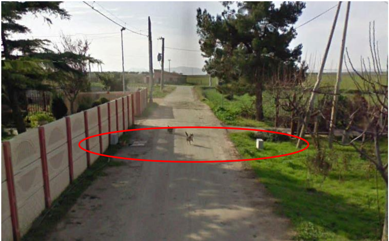
Fig. 35 Foto interferenza condotta idrica n 4
