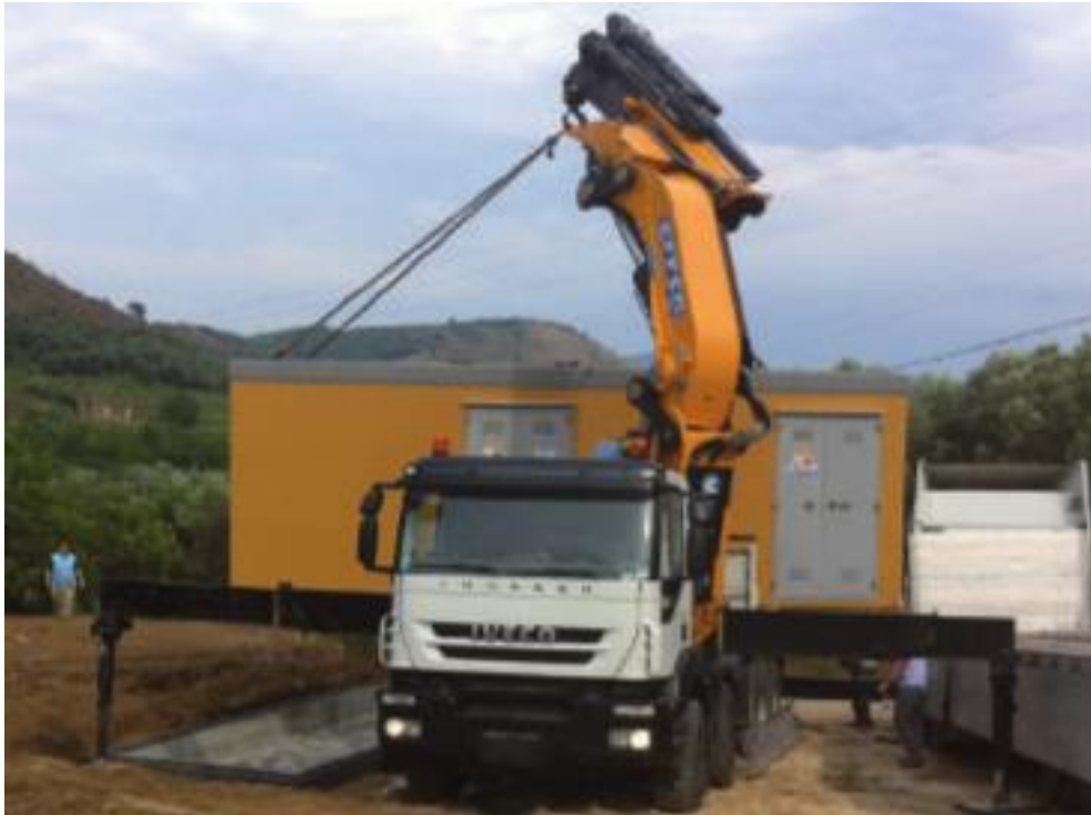
Fig. 20 Operazione di rimozione delle cabine prefabbricate
