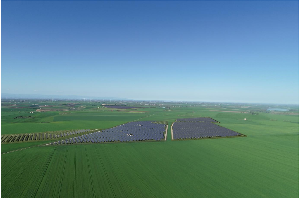
Figura 4-42: Punto di presa PVF03 - Lat. 41° 8' 11.890799999993"N - Long. 15° 45' 14.231800000000"E - Alt. 277.912 m. (POST)
