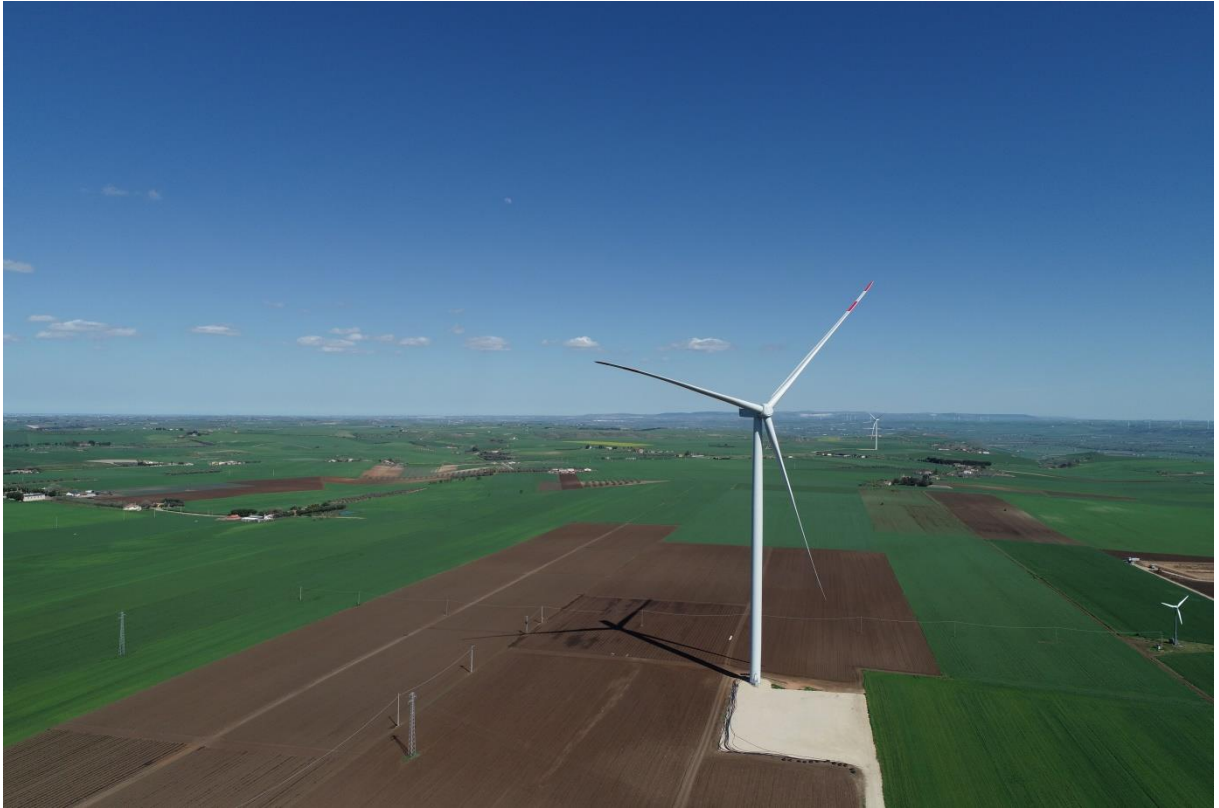
Figura 4-36: Punto di presa PVF01 - Lat. 41° 7' 21.0359999999992"N - Long. 15° 41' 51.423900000000"E - Alt. 307.319 m. (ANTE)
