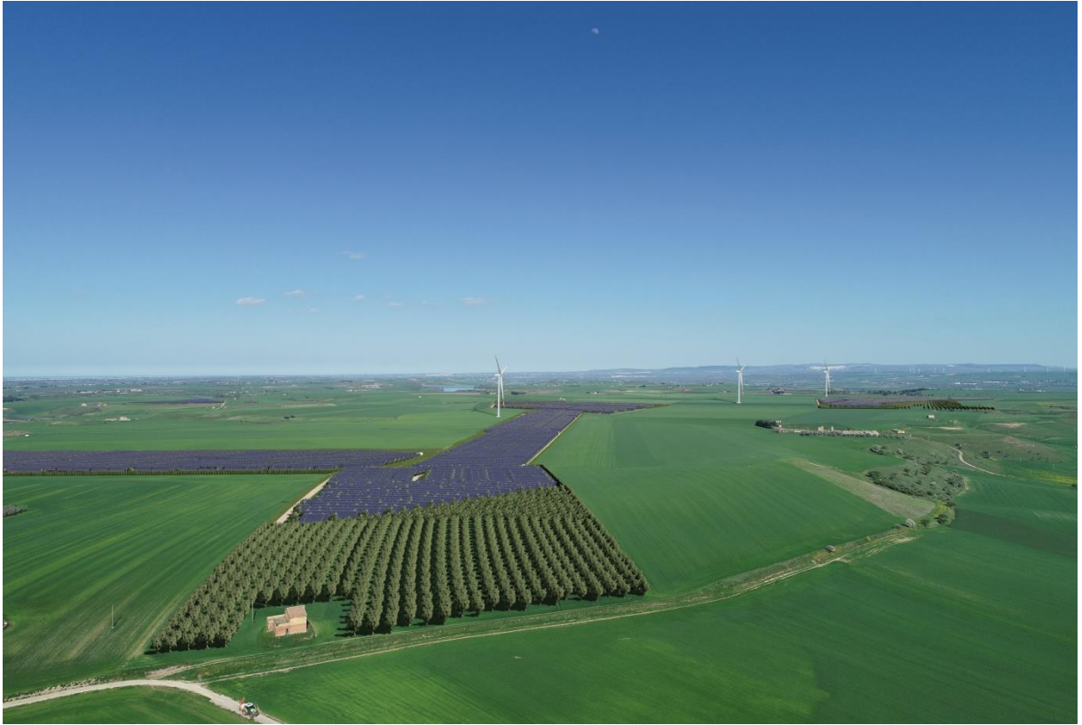
Figura 4-39: Punto di presa PVF02 - Lat. 41° 8' 23.126500000013"N - Long. 15° 44' 2.388200000001"E - Alt. 284.843 m. (POST)
