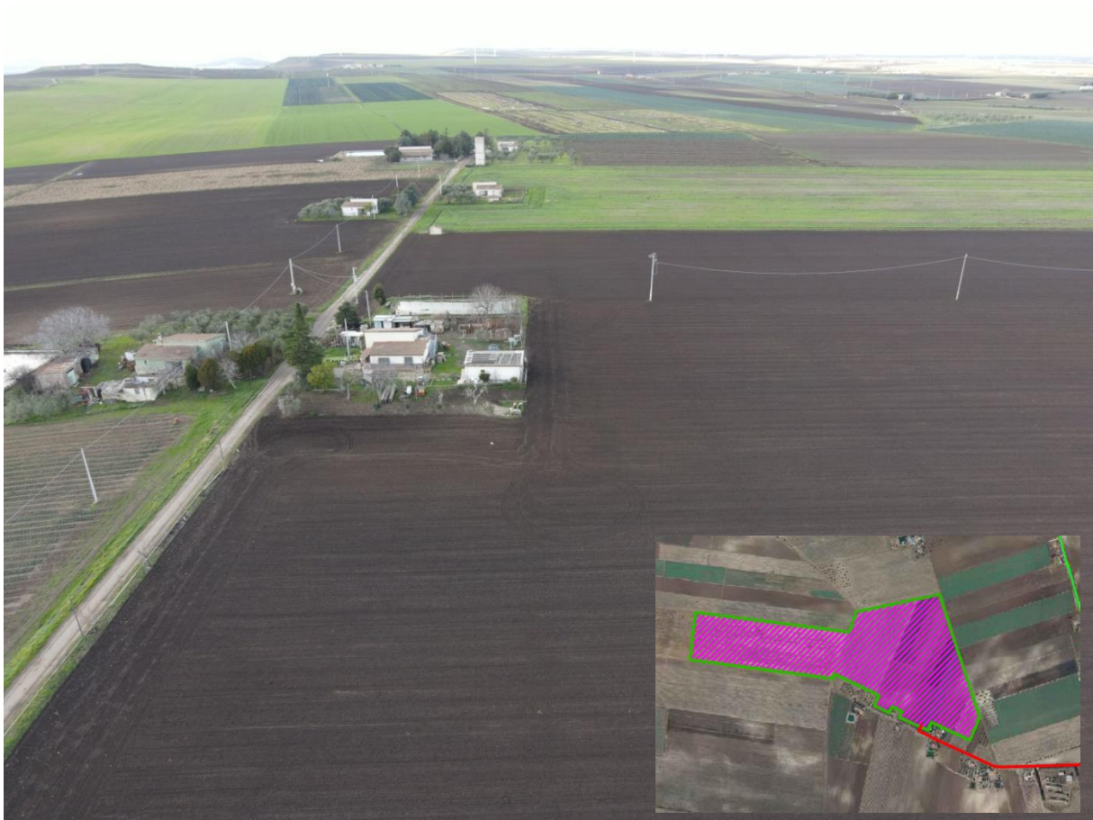
Figura 1-50: Foto da drone delle aree appartenenti al "Blocco E"
