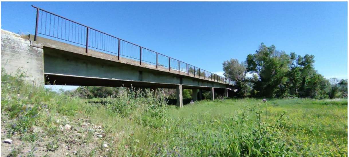
Figura 3-15: Ponte sul Fiume Ofanto (Cavidotto AT)
