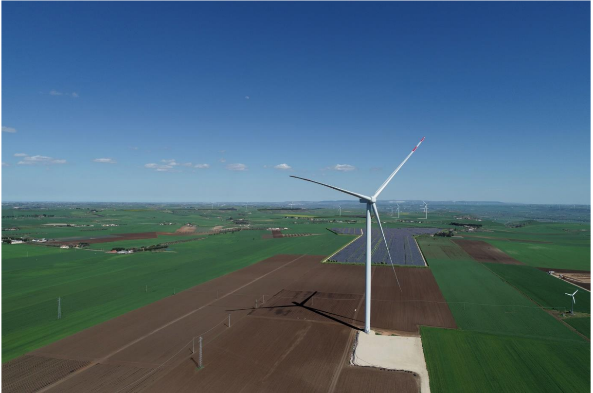
Figura 4-37: Punto di presa PVF01 - Lat. 41° 7' 21.0359999999992"N - Long. 15° 41' 51.423900000000"E - Alt. 307.319 m. (POST)
