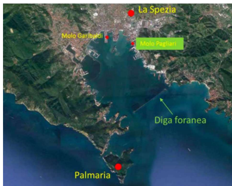
Figura 1 – Inquadramento generale dell'intervento in esame
