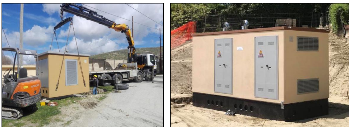
Figura 8 - Fasi di scarico cabine prefabbricate in cav
