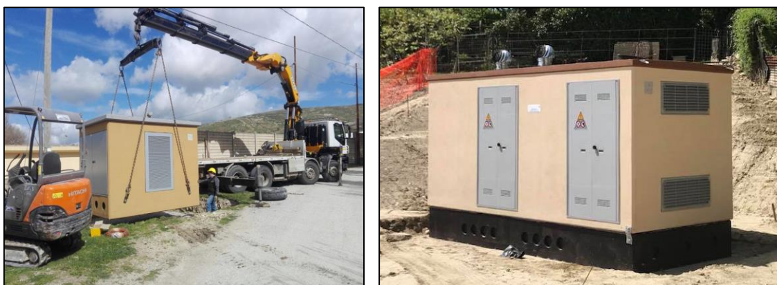
Figura 12 - Fasi di scarico cabine prefabbricate in cav
