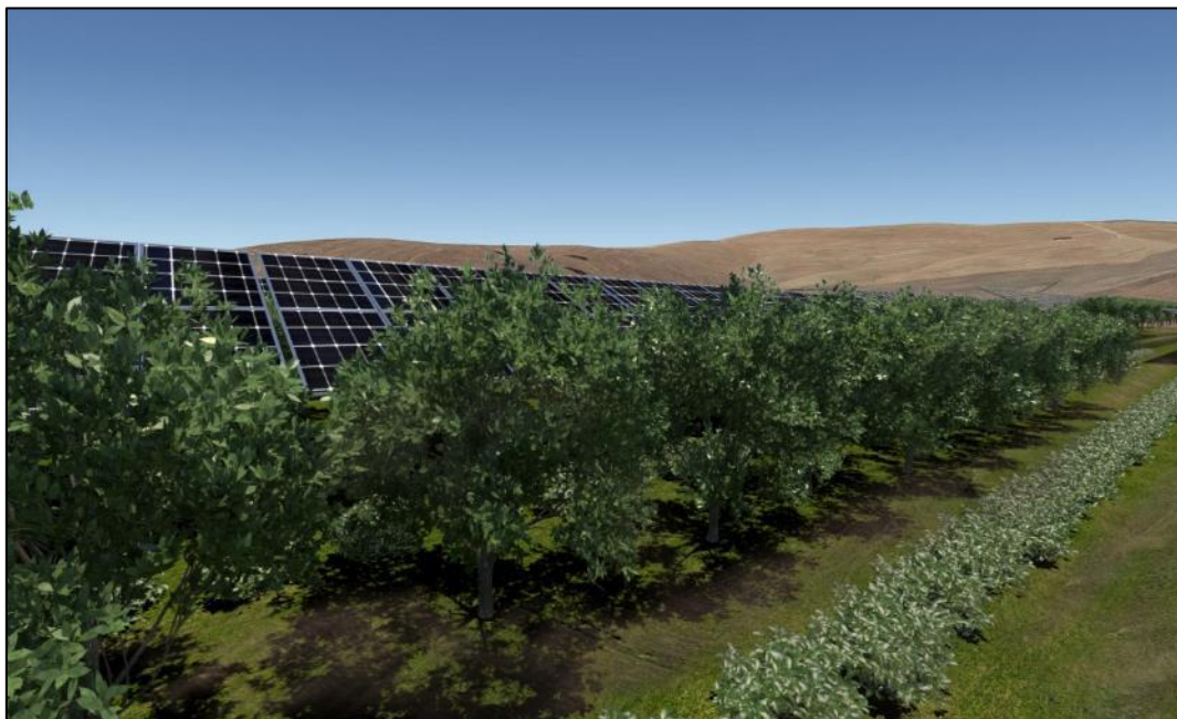
Figura 77 – mandorli messi in opera tra le file di moduli fotovoltaici
