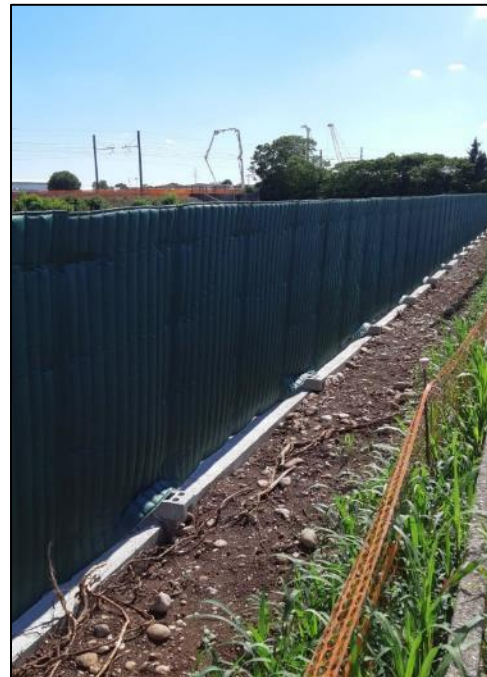
Figura 136 - Esempio di barriera fonoassorbente da utilizzare durante le operazioni che generano maggiori emissioni sulla componente "rumore"
