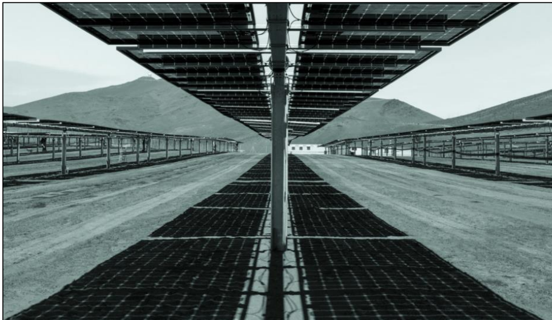
Figura 36 - Esempi di tracker per impianti fotovoltaici
