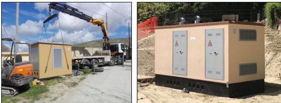
Figura 12 - Fasi di scarico cabine prefabbricate in cav
