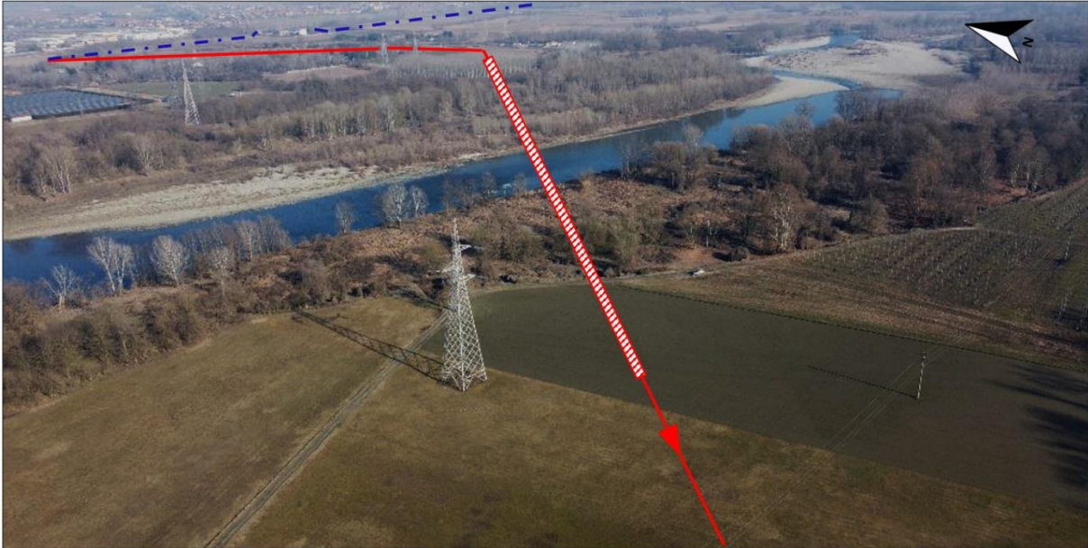
Figura 2.2/A – Immagine aerea del primo attraversamento del F. Po, microtunnel n. 1
