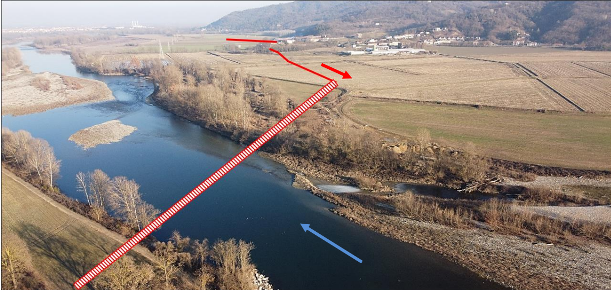
Figura 2.2/E – Immagine aerea del secondo attraversamento del F. Po, microtunnel n. 3
