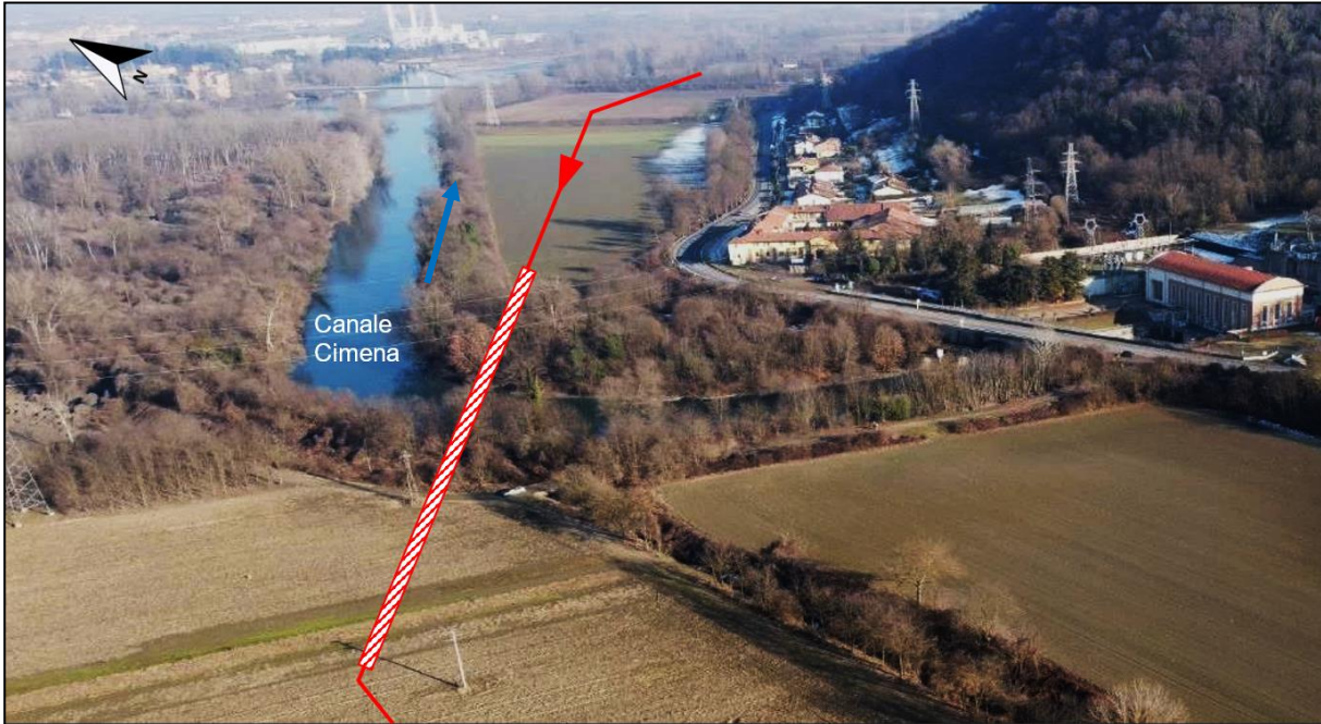
Figura 2.2/C – Immagine aerea dell'attraversamento del Canale Cimena, microtunnel n. 2
