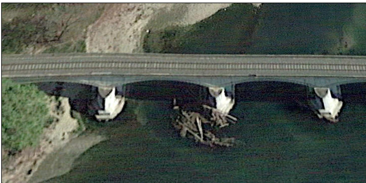
Figura 5.2/B – Ponte ferrovia Torino-Asti: particolare delle pile del ponte
