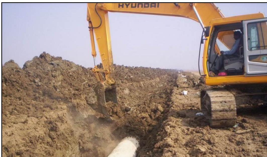
**Figura 8.1.9/A - Rinterro della condotta**
