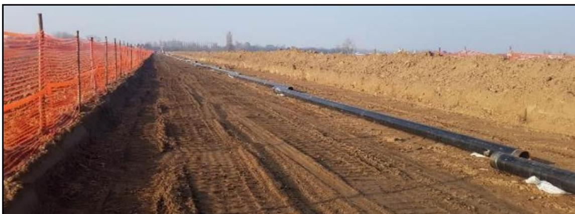
Foto 8.1.3/A – Sfilamento delle tubazioni di linea
