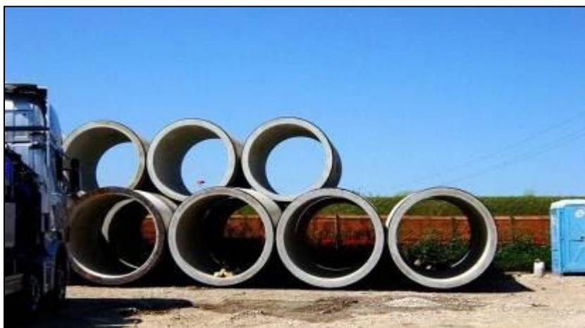
Figura 7.1.11/E – Stoccaggio tubi in c.a.
