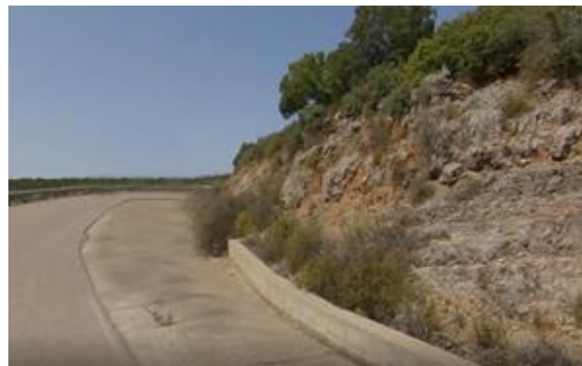
Simulazione cantiere temporaneo Fig.17:
