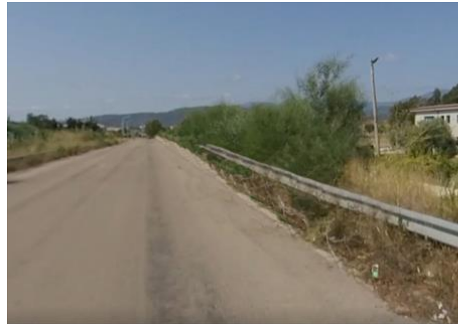
Simulazione cantiere temporaneo Fig.4:
