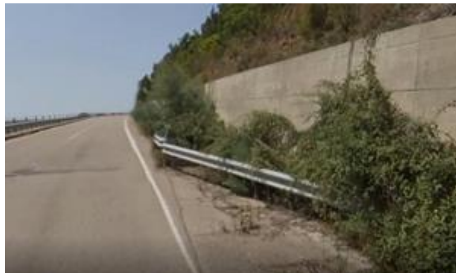
Simulazione cantiere temporaneo Fig.16:
