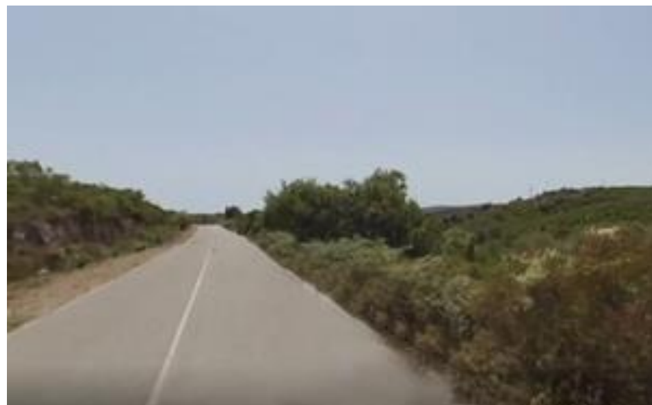
Simulazione cantiere temporaneo Fig.18:
