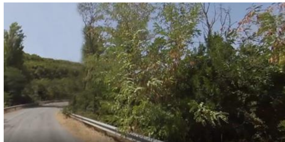
Simulazione cantiere temporaneo Fig.11:
