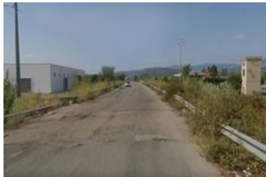
Simulazione cantiere temporaneo Fig.19:
