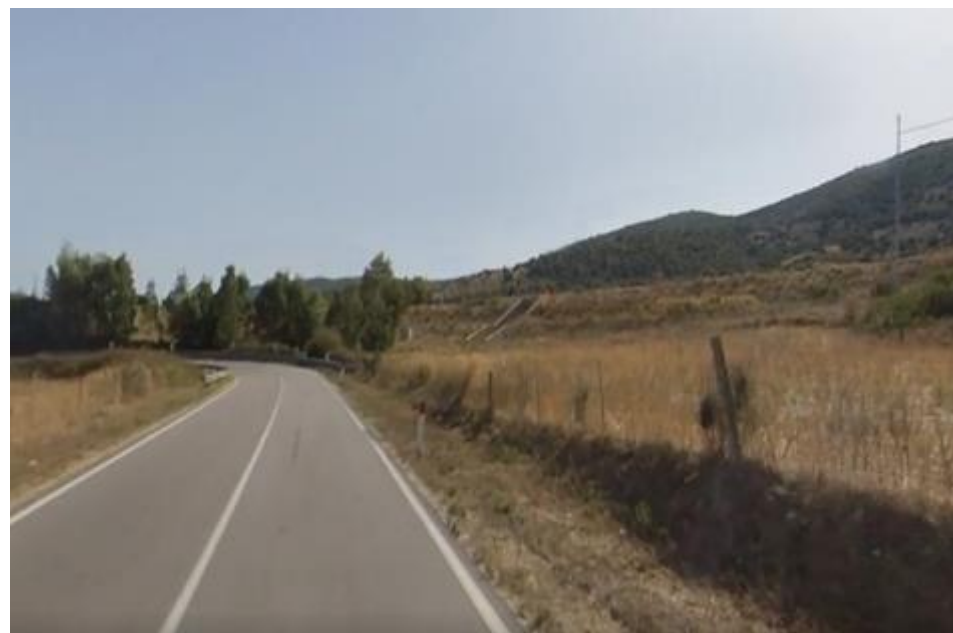
Simulazione cantiere temporaneo Fig.22:
