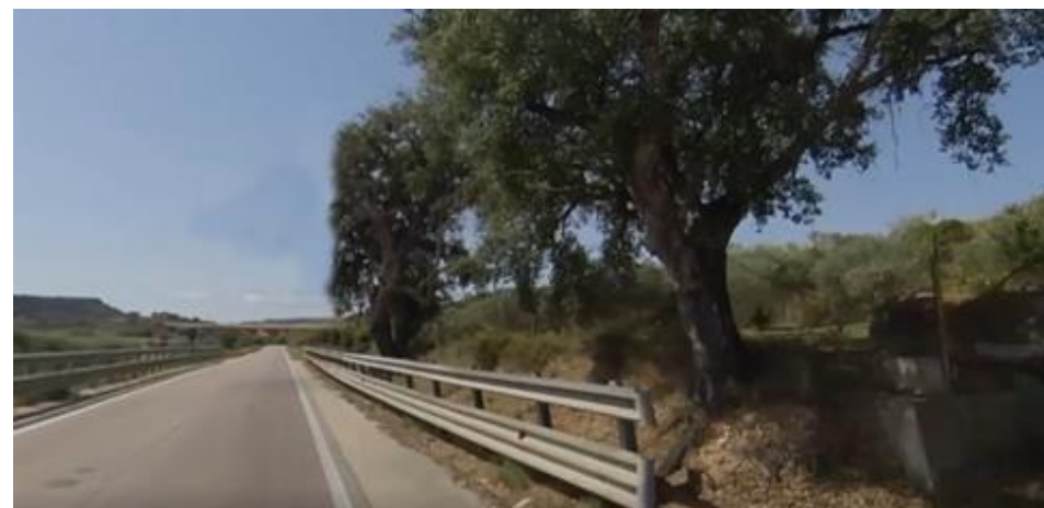
Simulazione cantiere temporaneo Fig.10:
