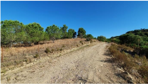
Figura 96. Tracciato del cavidotto presso WTG009, vista da S.
