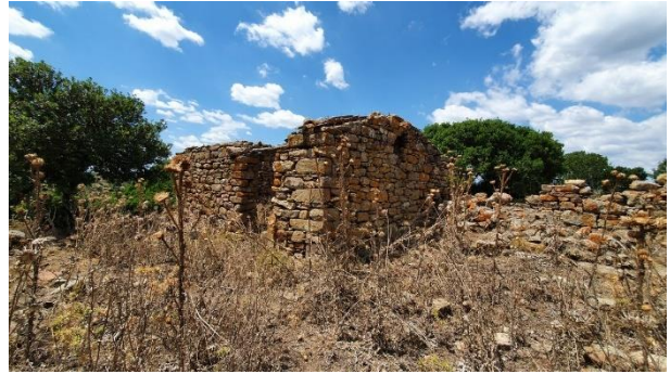
Figura 35. Su Coili de Sorrosu, vista da E.
