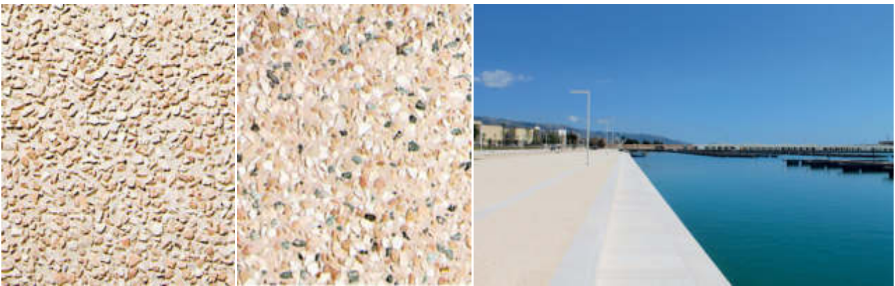
Figura 6: Pavimentazione tipo “sasso lavato”
