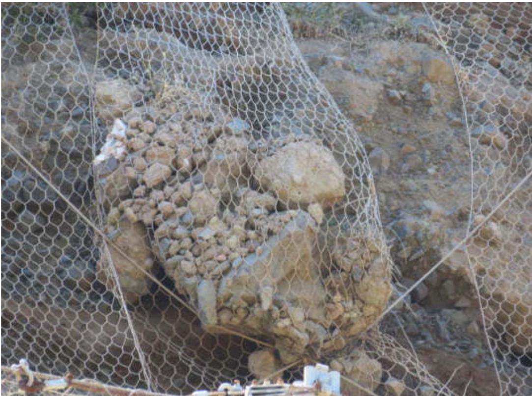
*Fig. 2 Distacco parte del consolidamento roccioso*
