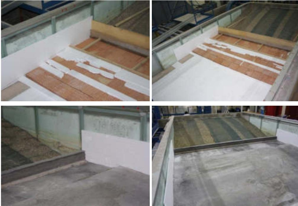
Fasi di realizzazione del fondo: la parte interna viene realizzata con forati e pannelli di polistirolo che successivamente vengono ricoperti da uno strato di cemento.
