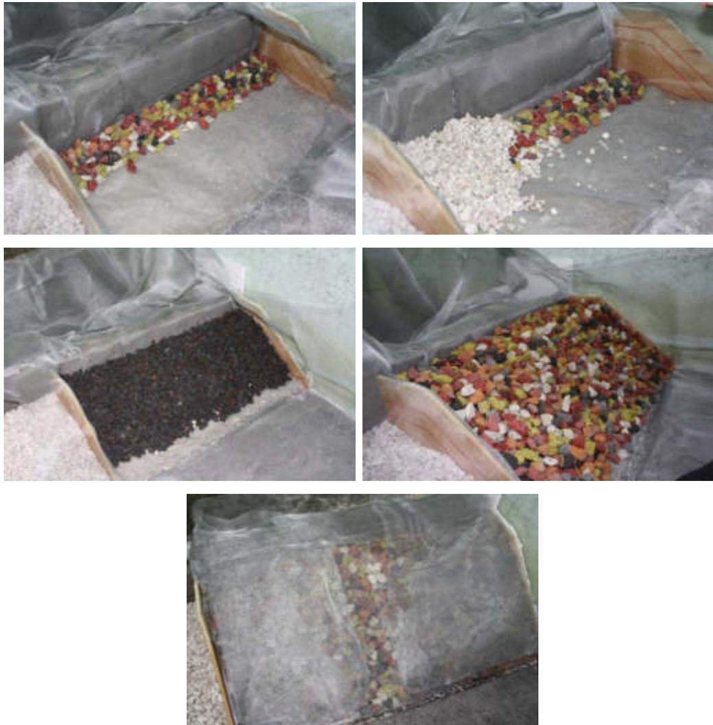
**Figura 4.20** Sistemazione delle parti laterali e protette mediante rete metallica a maglie quadrate
