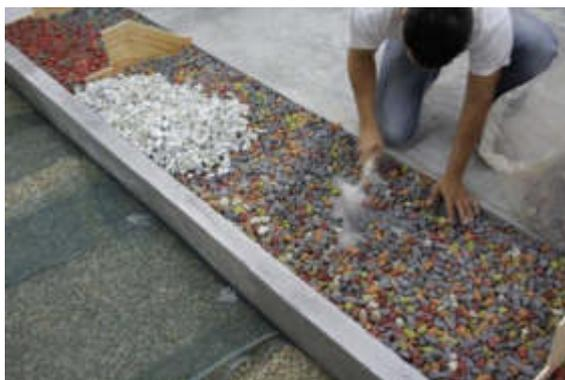
**Figura 4.14** Riempimento della struttura in calcestruzzo mediante materiale basaltico ( $D=20-30$  mm).
