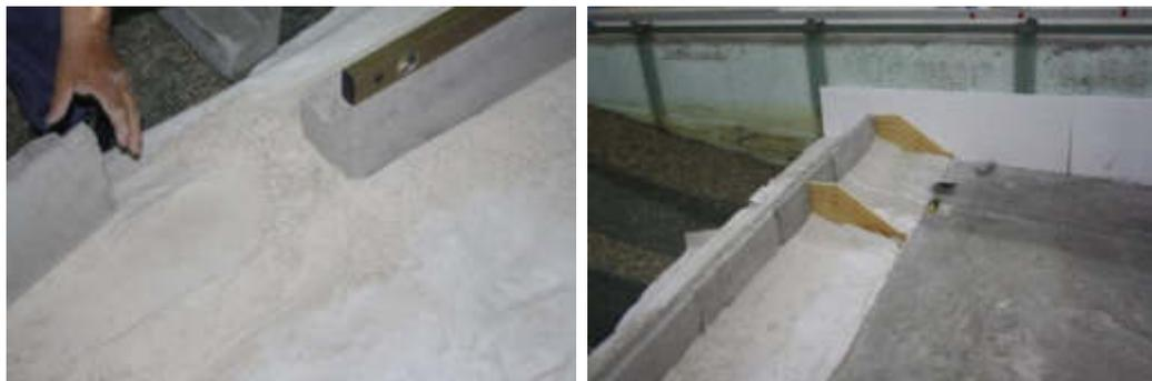
**Figura 4.17** Posa del muro paraonde su uno strato di sabbia in modo da facilitare la sistemazione allineata dei singoli moduli.
