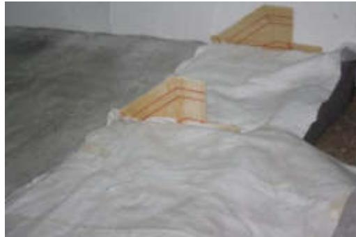
**Figura 4.16** Ricoprimento del piano di posa con del geotessuto, per evitare il trasporto di materiale e la conseguente modifica del piano stesso.
