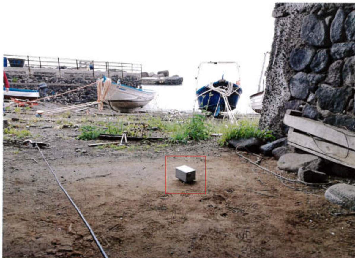
Ubicazione del sensore nel punto di misura MT2
