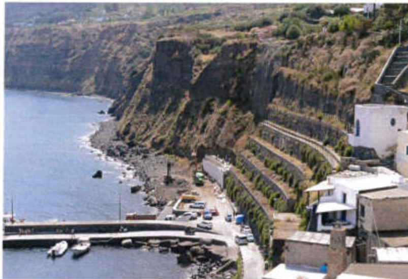
Panoramica sugli interventi di consolidamento eseguiti nell'area di Scalo Galera
