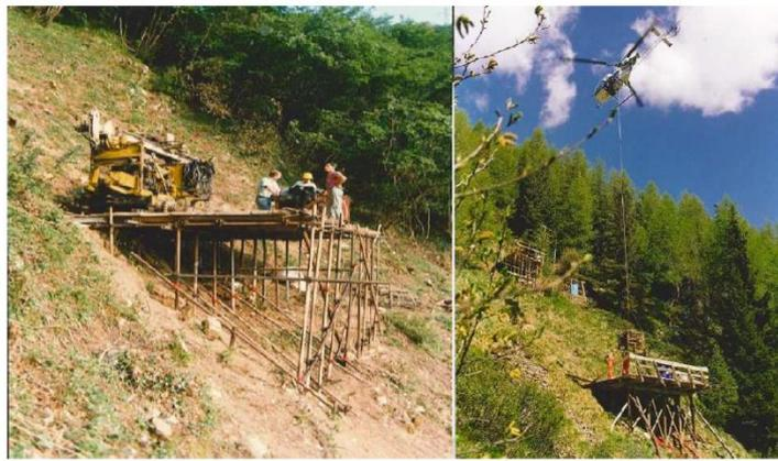
Figura 5. Esempio di piazzola di lavoro e stoccaggio.
