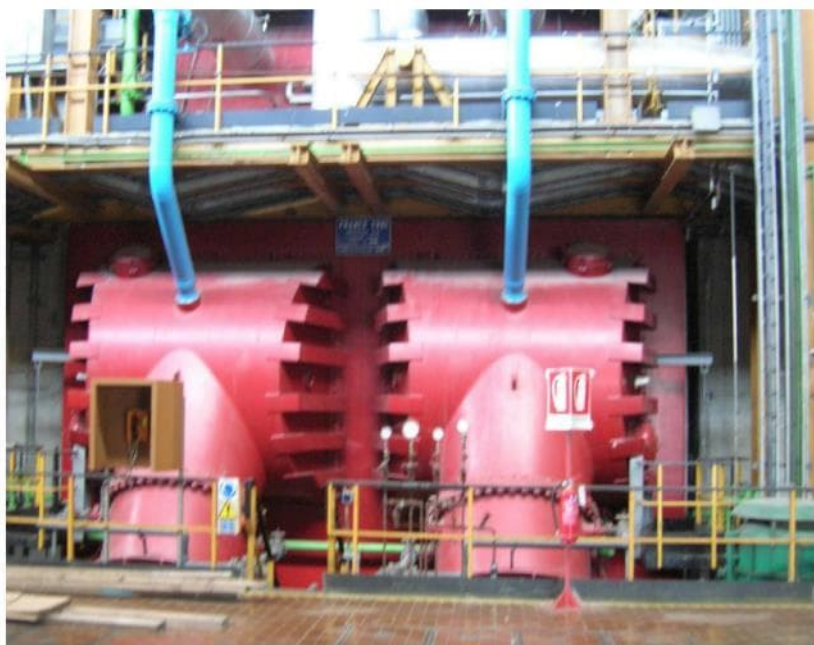
Figura 19: Condensatore del Gruppo 8 - Prima della rimozione (per permettere il riutilizzo del circuito acqua di circolazione al nuovo gruppo TZnew)
