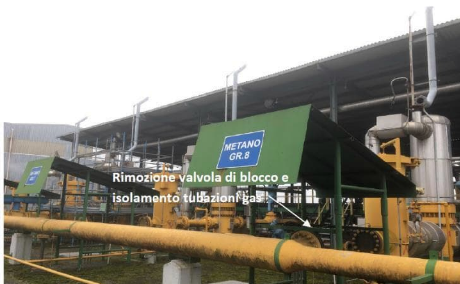
Figura 7: Vista sezionamento mandata a Gruppo 8
