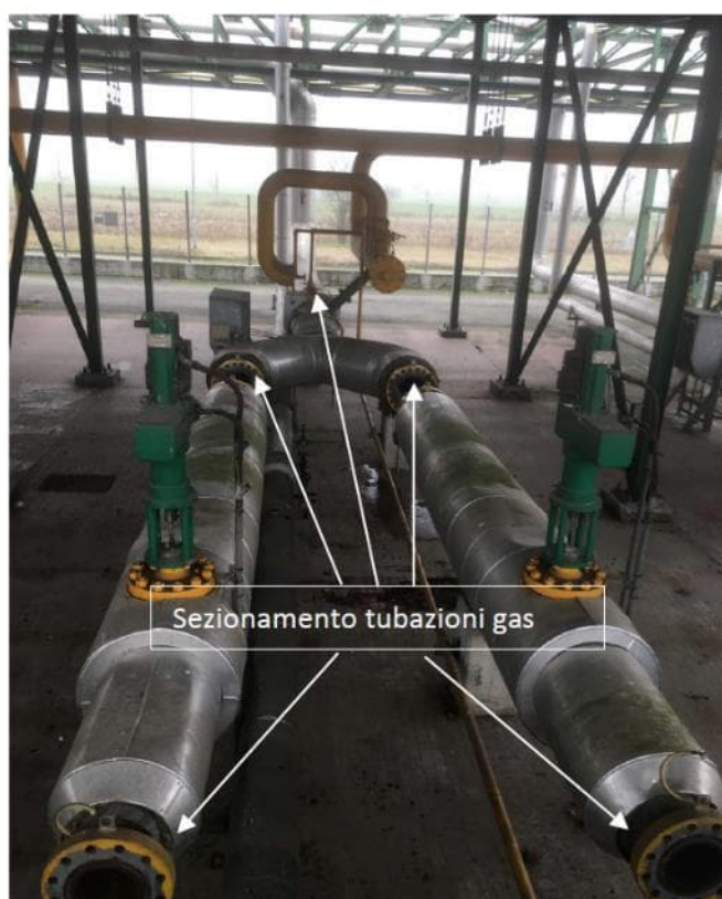
Figura 8: Vista interna dei sezionamenti
