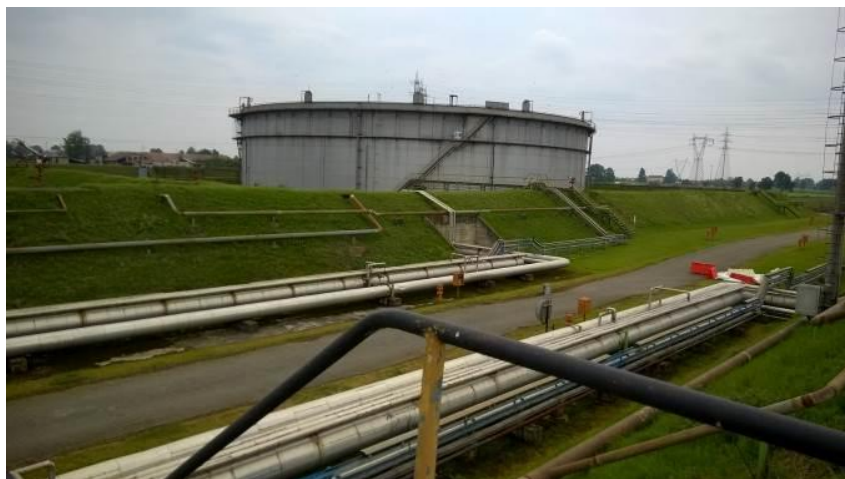
Figura 24: Serbatoio S3 e tubazioni collegamento con tettoia (Tavola D).
