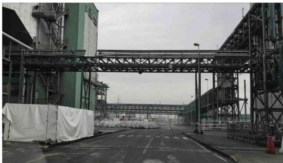
Figura 11: Pipe rack zona adiacente al Gruppo 8 - Prima della demolizione del pipe rack
