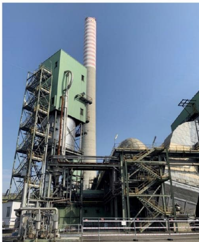
Figura 15: Silos di accumulo ceneri Gruppo 8 - Prima della rimozione
