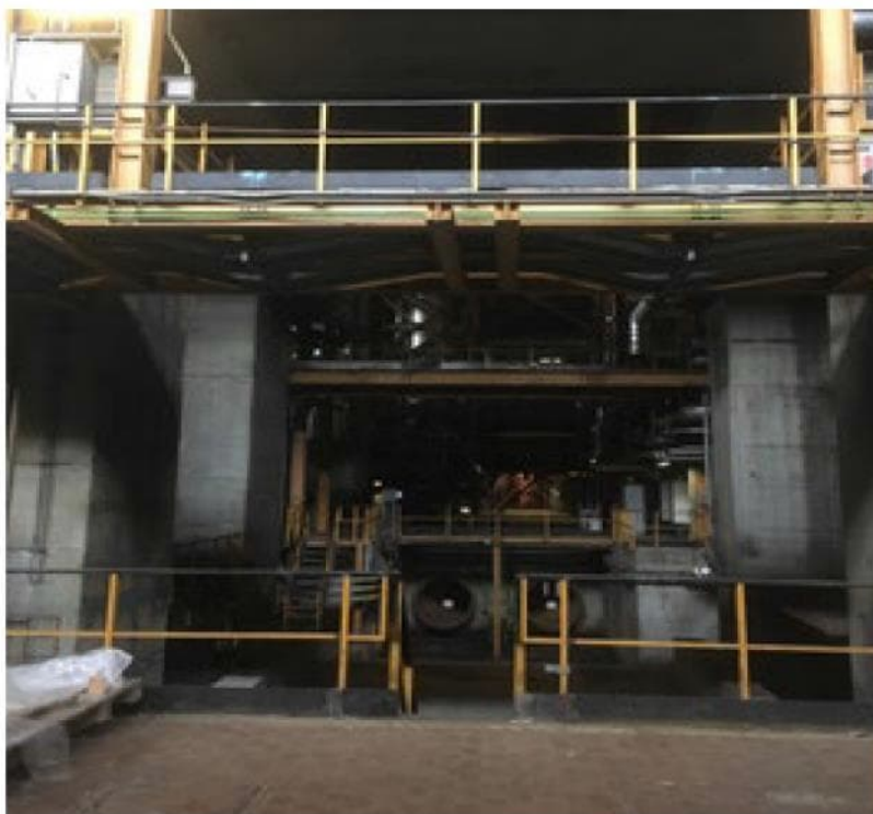
Figura 20: Condensatore del Gruppo 8 - Dopo la rimozione
