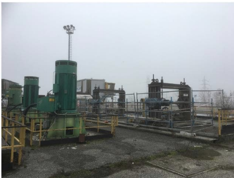
Figura 22: Opera di presa del Gruppo 8 - Revamping in corso
