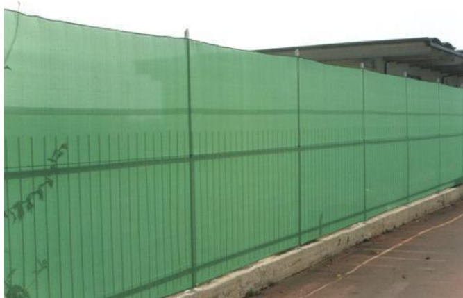
Figura 31: Esempio di telo antipolvere.
