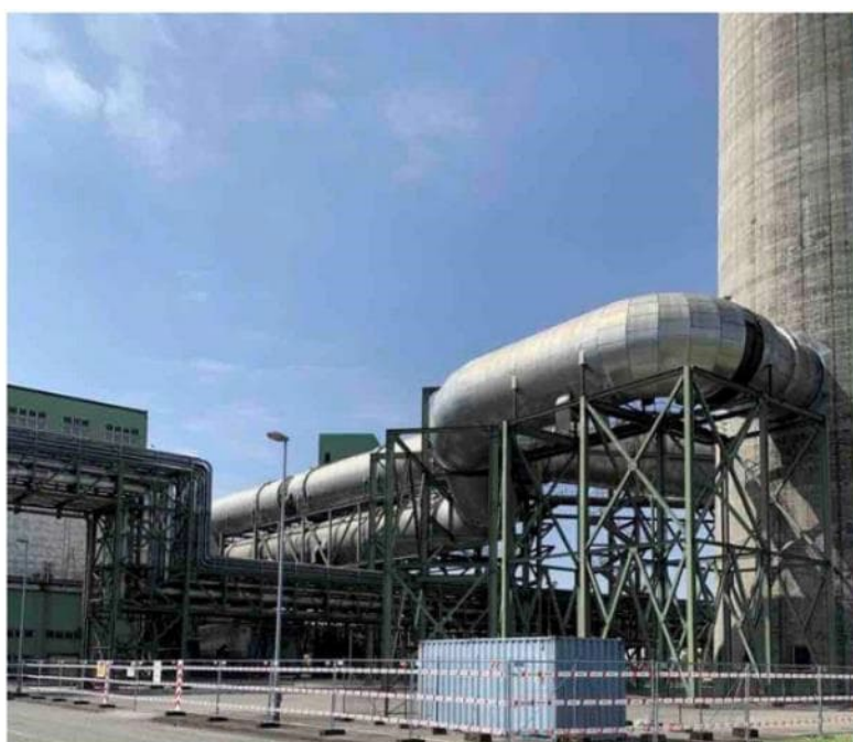
Figura 17: Condotti di scarico fumi Gruppo 8 - Prima della rimozione
