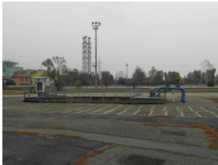
VASCA RACCOLTA E RILANCIO ACQUE METEO INQUINABILI DA OCD (tipica)
