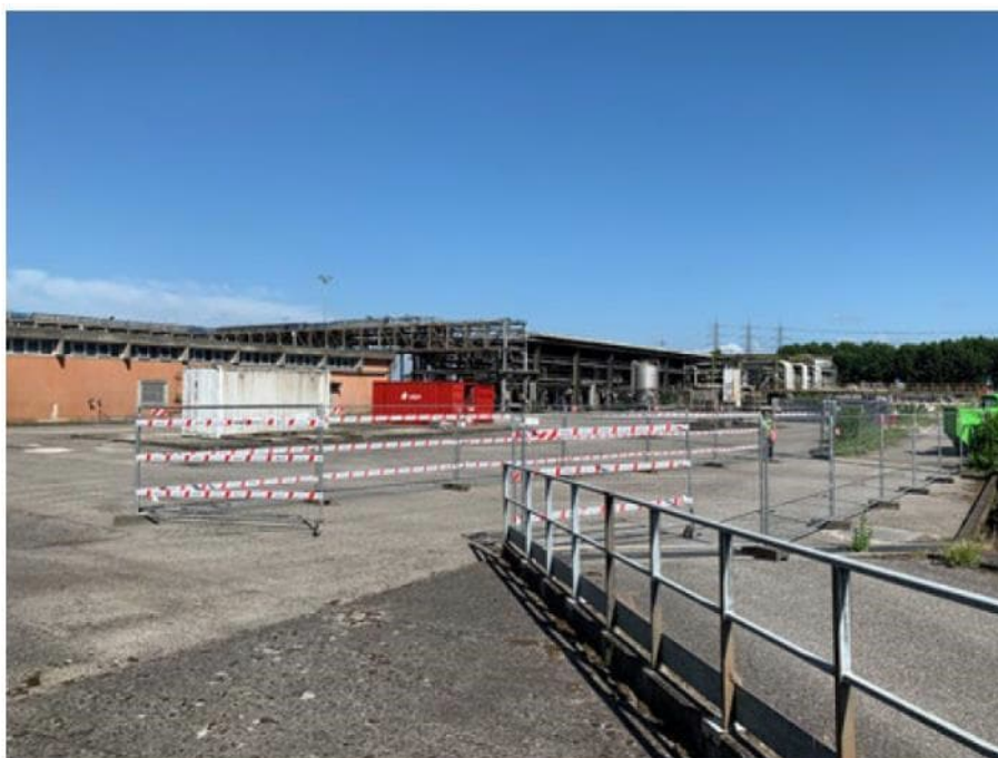
Figura 23: Pensilina Parco Combustibili Nord - Prima della demolizione
