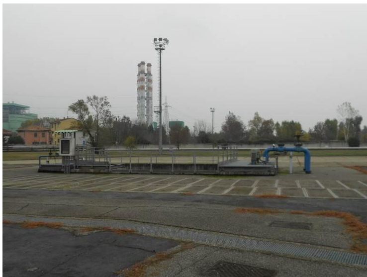
Figura 9: Vasca raccolta e rilancio acque meteo inquinabili da OCD (tipica).
