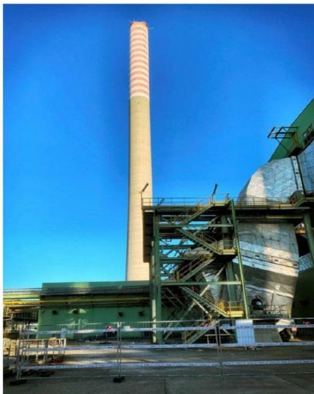
Figura 16: Silos di accumulo ceneri Gruppo 8 - Dopo la rimozione
