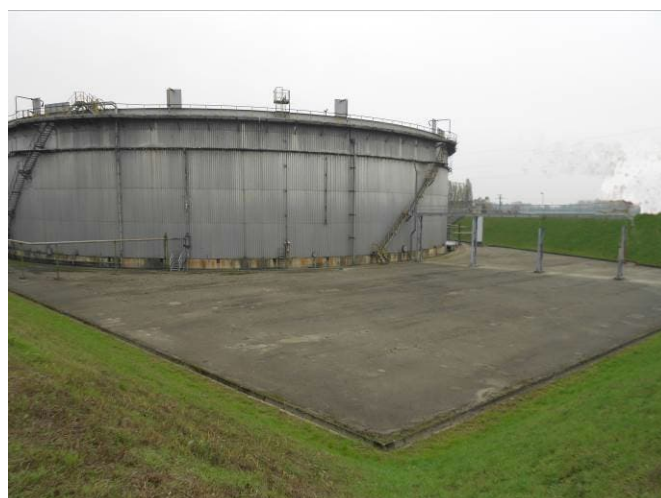
PIAZZALE AREA BACINI SERBATOI 50.000MC
