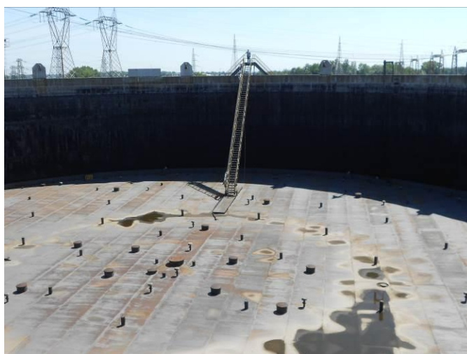
Figura 20: Vista parte superiore tetto galleggiante.
