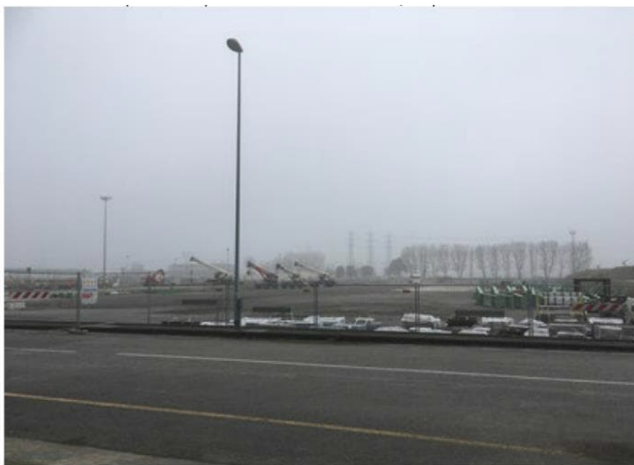
Figura 24: Pensilina Parco Combustibili Nord - Dopo la demolizione
