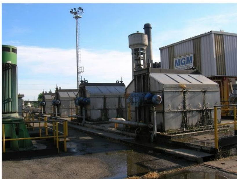
Figura 21: Opera di presa del Gruppo 8 - Prima del revamping (da adibire al funzionamento del nuovo gruppo TZnew)
