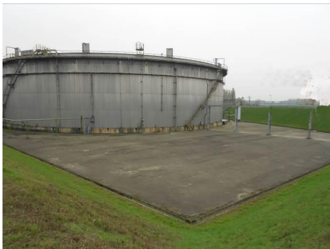
Figura 19: Piazzale area bacini serbatoi 50.000 m 3 .
