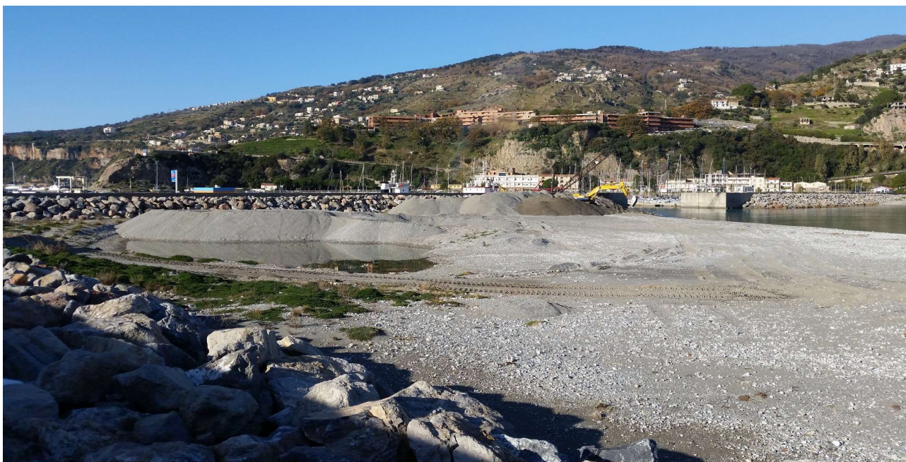
Figura 4-8 Accumulo del materiale dragato
