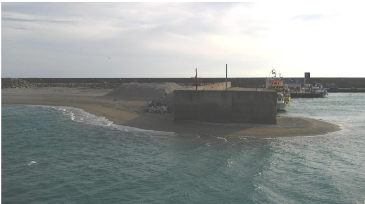
Figura 9.6 Accumulo di sedimenti tra il sopraflutto e l'imboccatura
