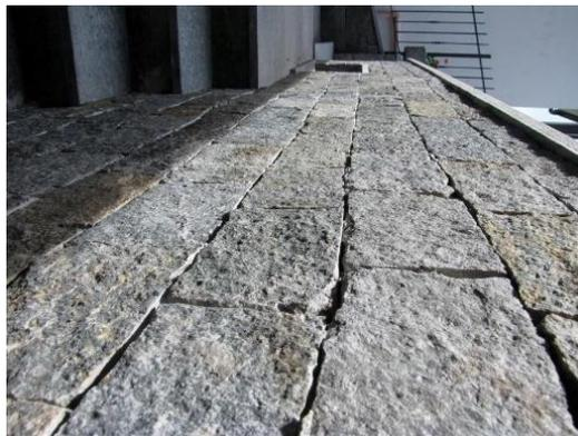
*Figura 26 - Rivestimento delle banchine*
