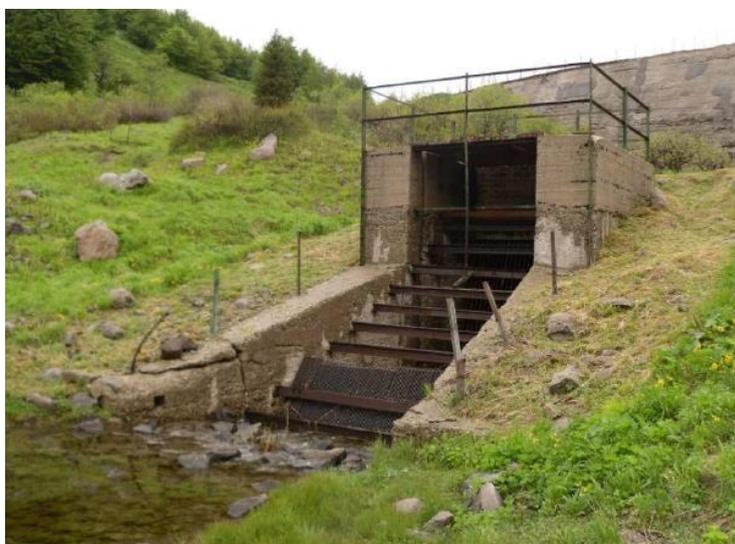
Figura 20 Imbocco dello scarico di fondo
