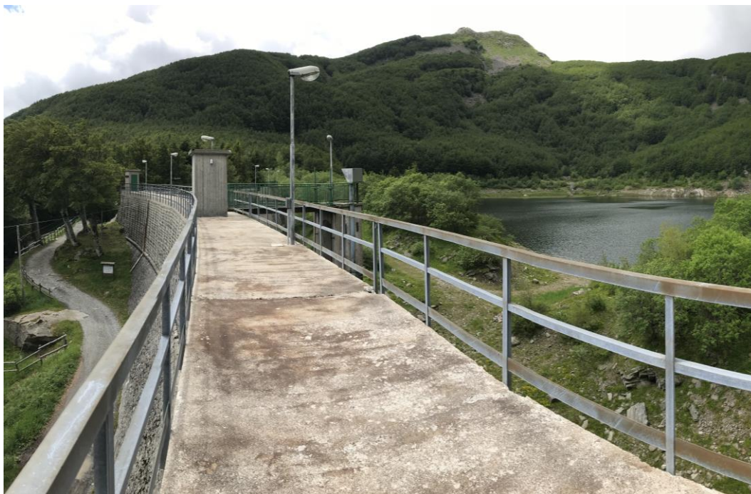
Figura 3.14 Coronamento della diga
