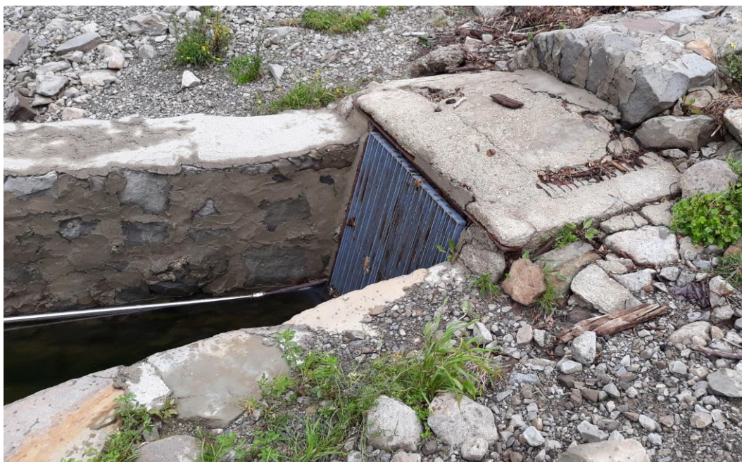
Figura 3.18 Imbocco dello scarico di fondo e opera di presa
