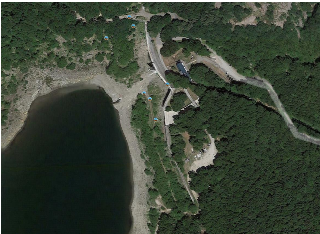
Figura 9.1 Vista aerea dello sbarramento
