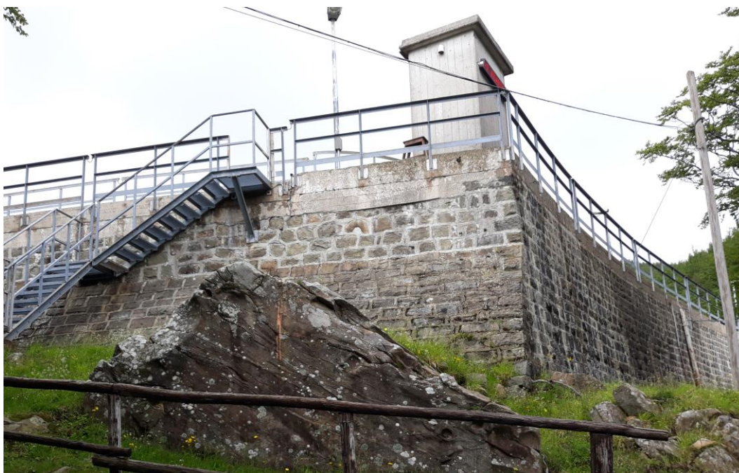
Figura 3.15 Paramento di valle della diga
