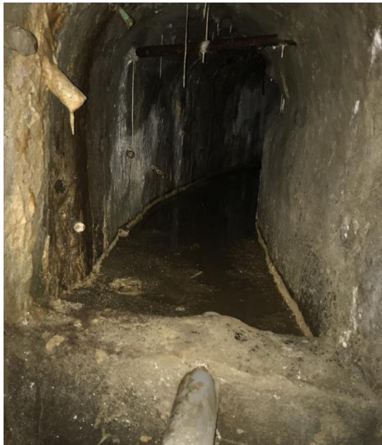
Figura 3.21 Galleria di drenaggio
