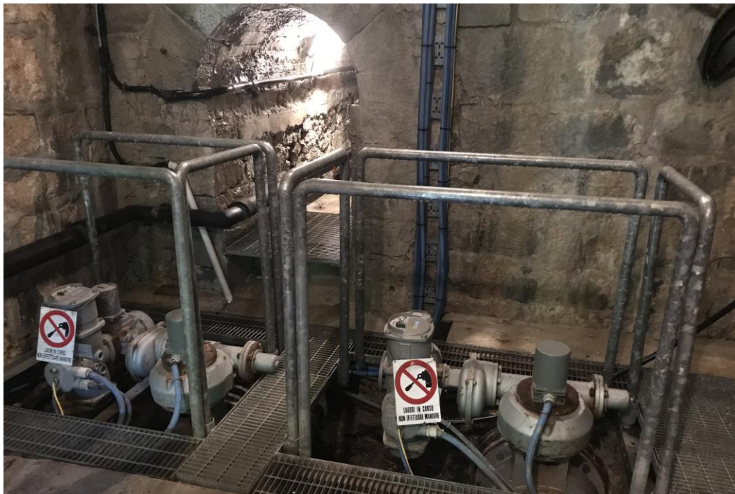
Figura 3.20 Camera di manovra
