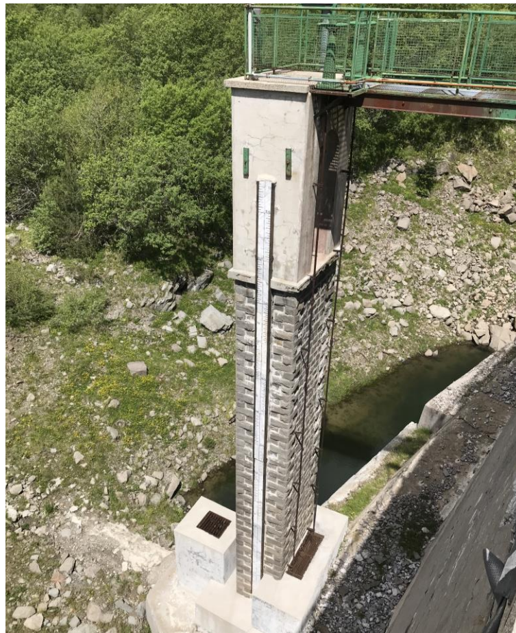
Figura 3.19 Torre di manovra
