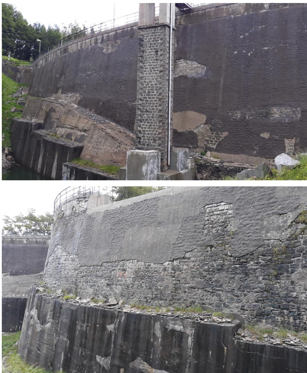
Figura 3.13 In alto il paramento di monte della diga principale. In basso il paramento di monte dell'argine secondario
