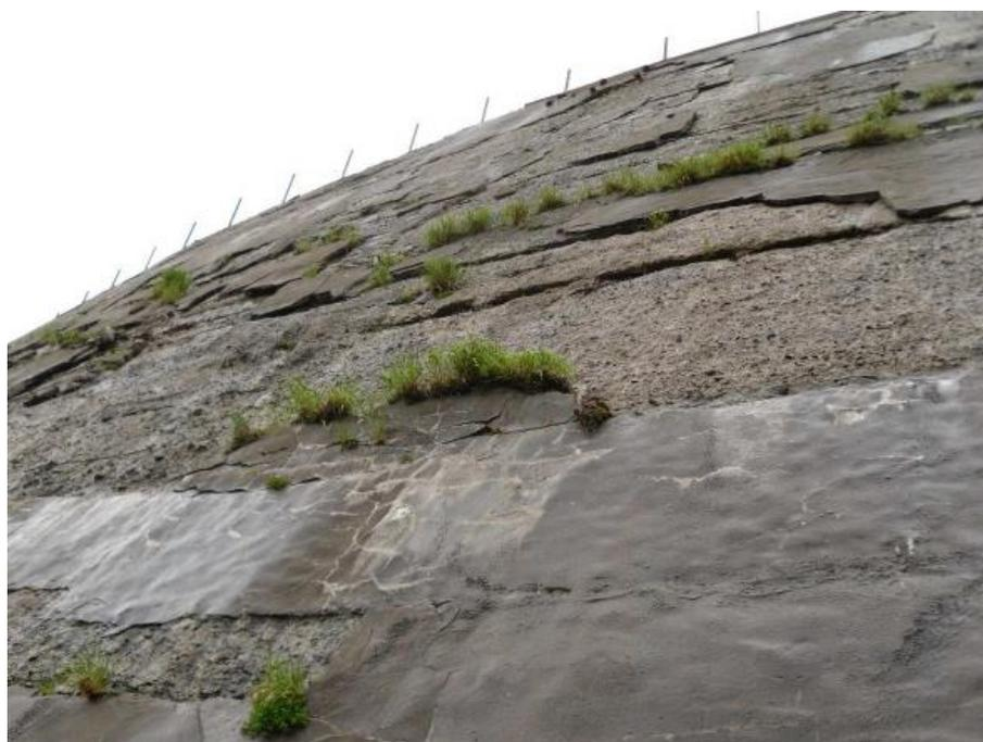
**Figura 21 – Particolare del paramento di monte**
