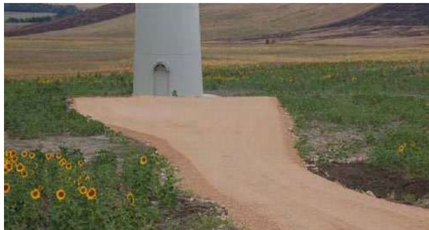
Fig -3: ripristino con inverdimento
