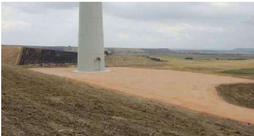
Fig 2: fase di cantiere
