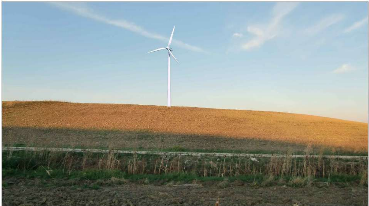
FIGURA 15 – Vista panoramica Aerogeneratore (WTG 4)
