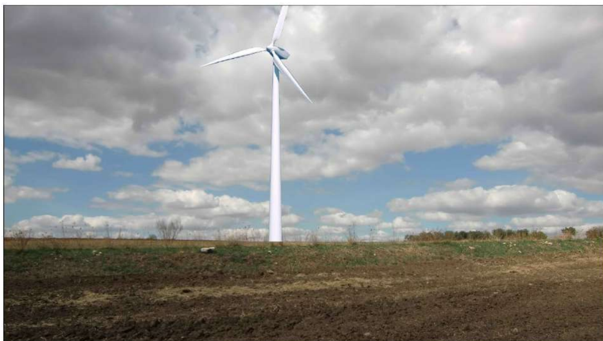
FIGURA 12 – Vista panoramica Aerogeneratore (WTG 1)
