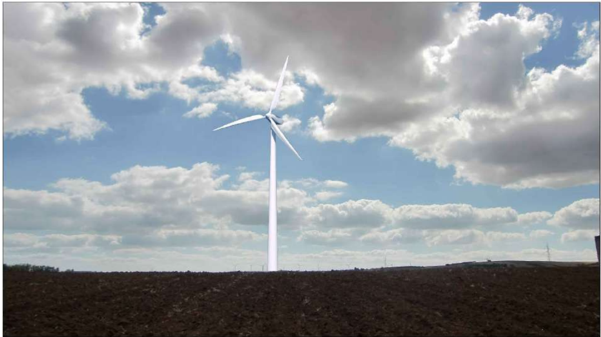
FIGURA 16 – Vista panoramica Aerogeneratore (WTG 5)
