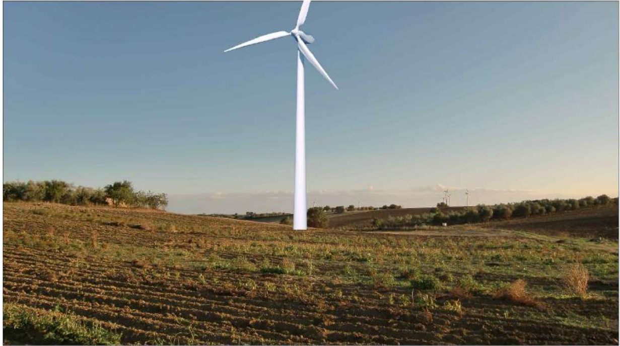
FIGURA 14 – Vista panoramica Aerogeneratore (WTG 3)
