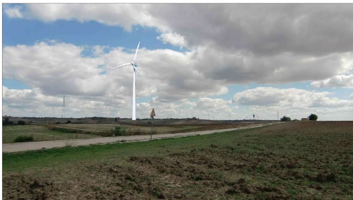
FIGURA 13 – Vista panoramica Aerogeneratore (WTG 2)
