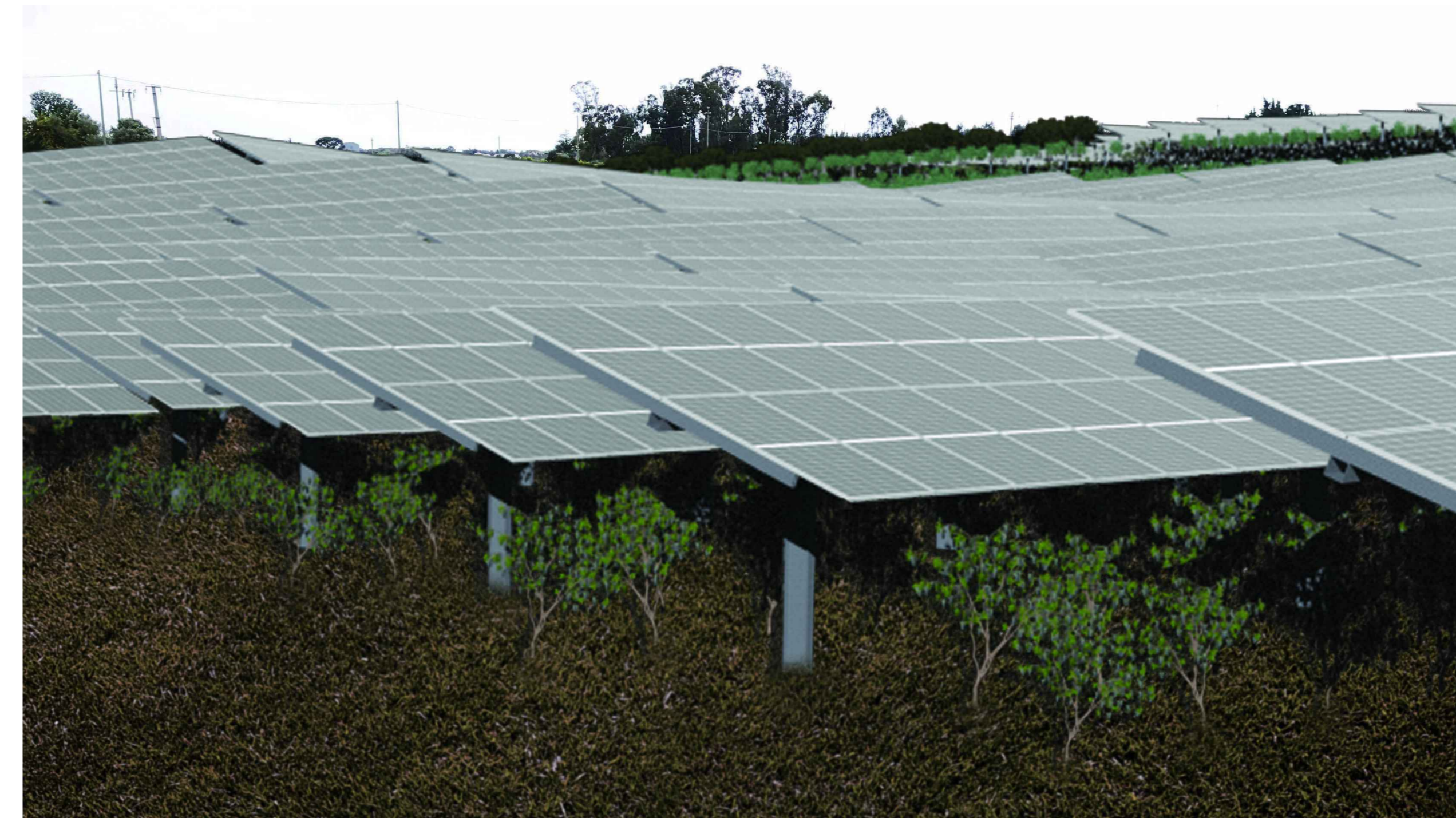
L FOTO PUNTO DI VISTA 7 - POST OPERAM
