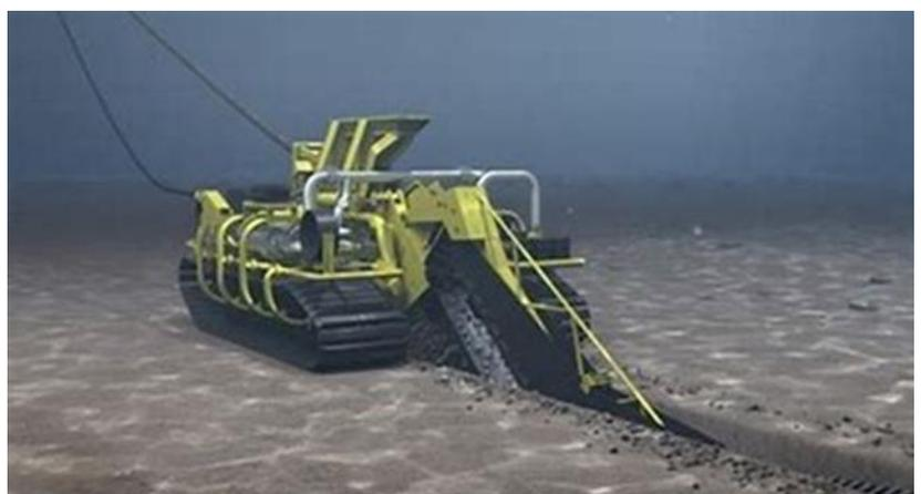
Figura 38: Posa del cavo 220kV AC;
