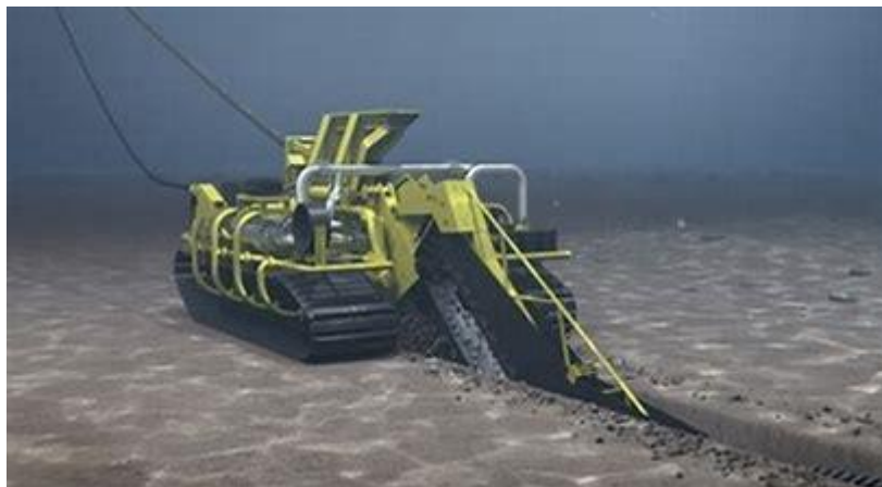
Figura 39 - posa del cavo 220 kV AC
