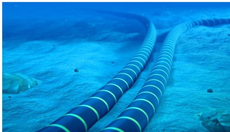
Figura 22 - cavo marino con isolamento in XLPE posato sul fondo
