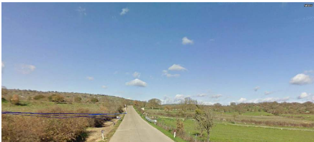
Figura 50 - Foto dalla S.P.107 in prossimità dell'accesso agli aerogeneratori B05 e B06
