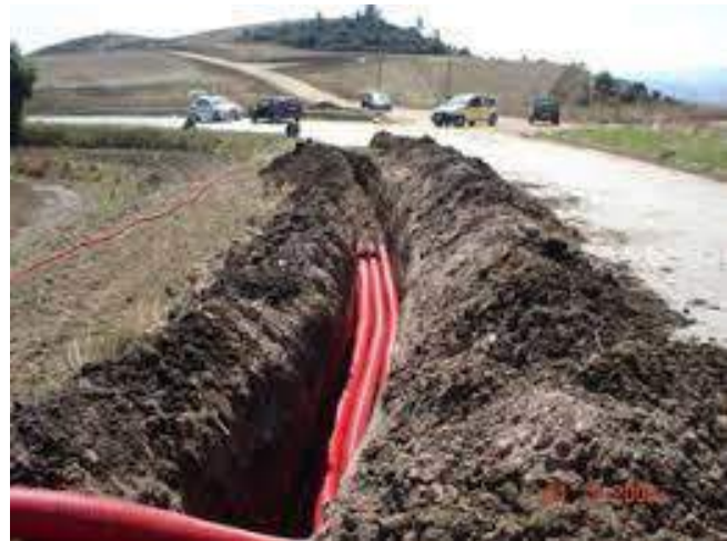
Figura 79 - Posa cavidotto MT tipo
