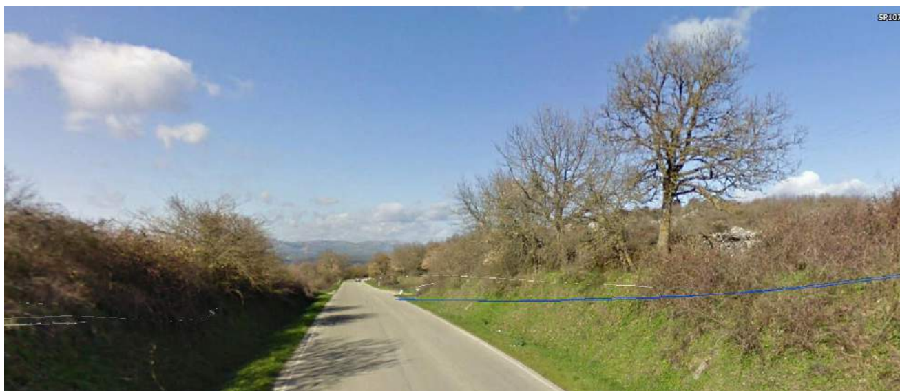
Figura 49 - Foto dalla S.P.107 in prossimità dell'accesso agli aerogeneratori B03 e B04
