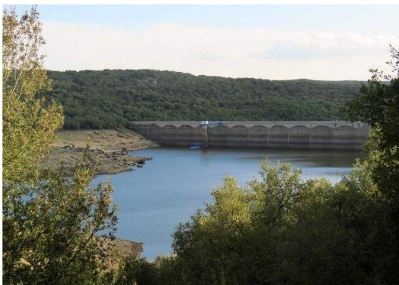
Figura 128 – Diga Sos Canales – Buddusò
