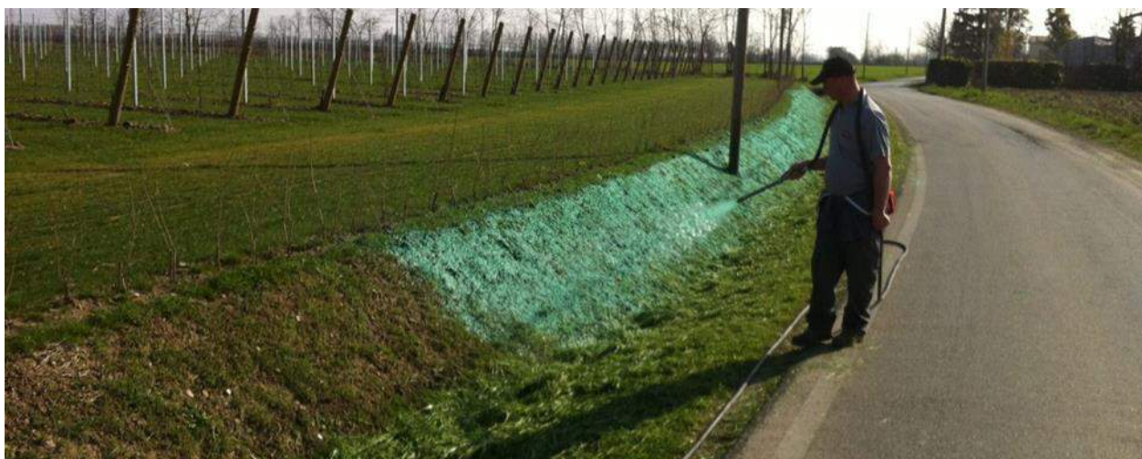
Figura 100 - Sistema di idrosemina
