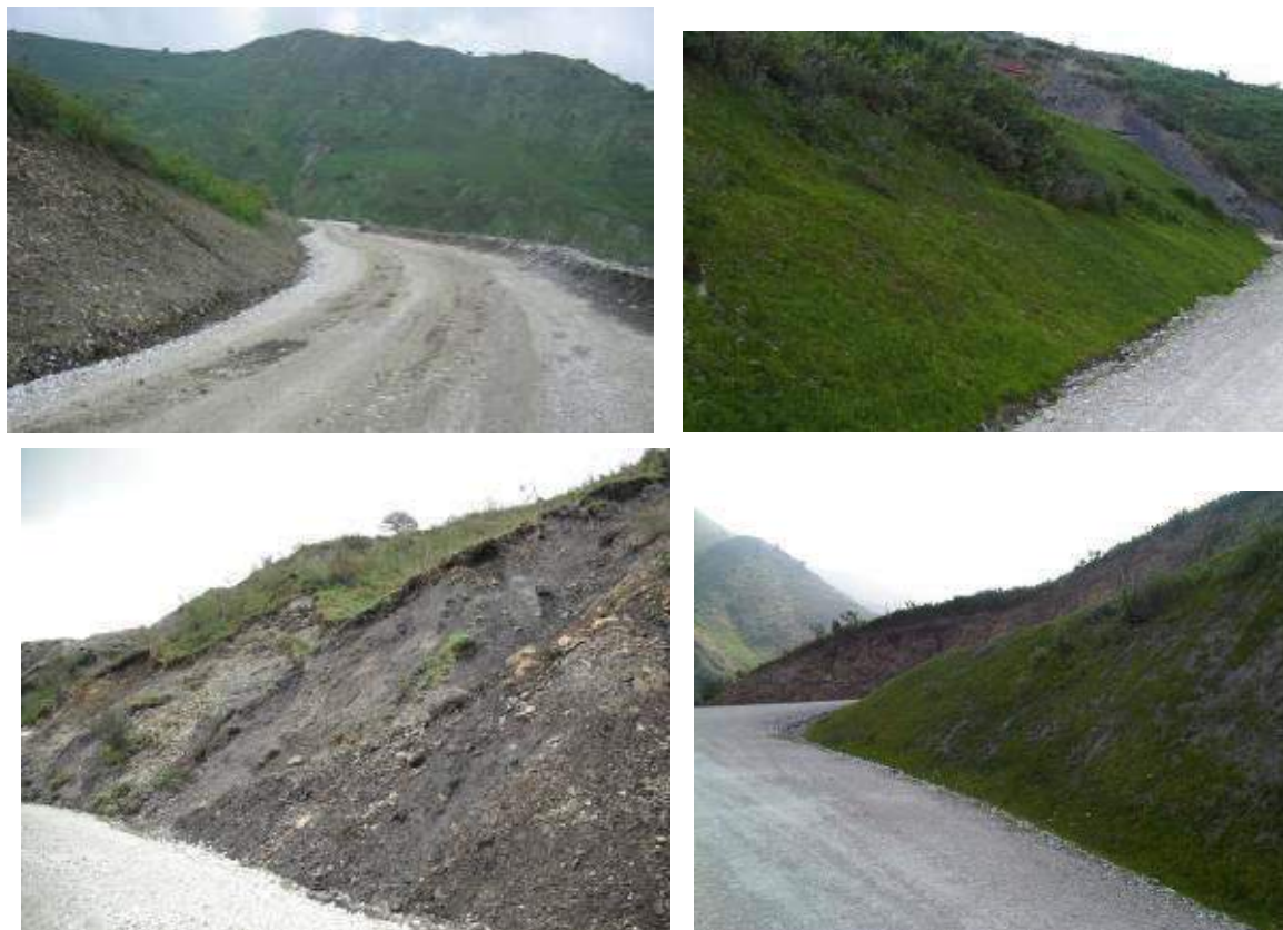
Fig. 89 - Esempi di inerbimento post operam delle scarpate oggetto di intervento, ove e se necessari
