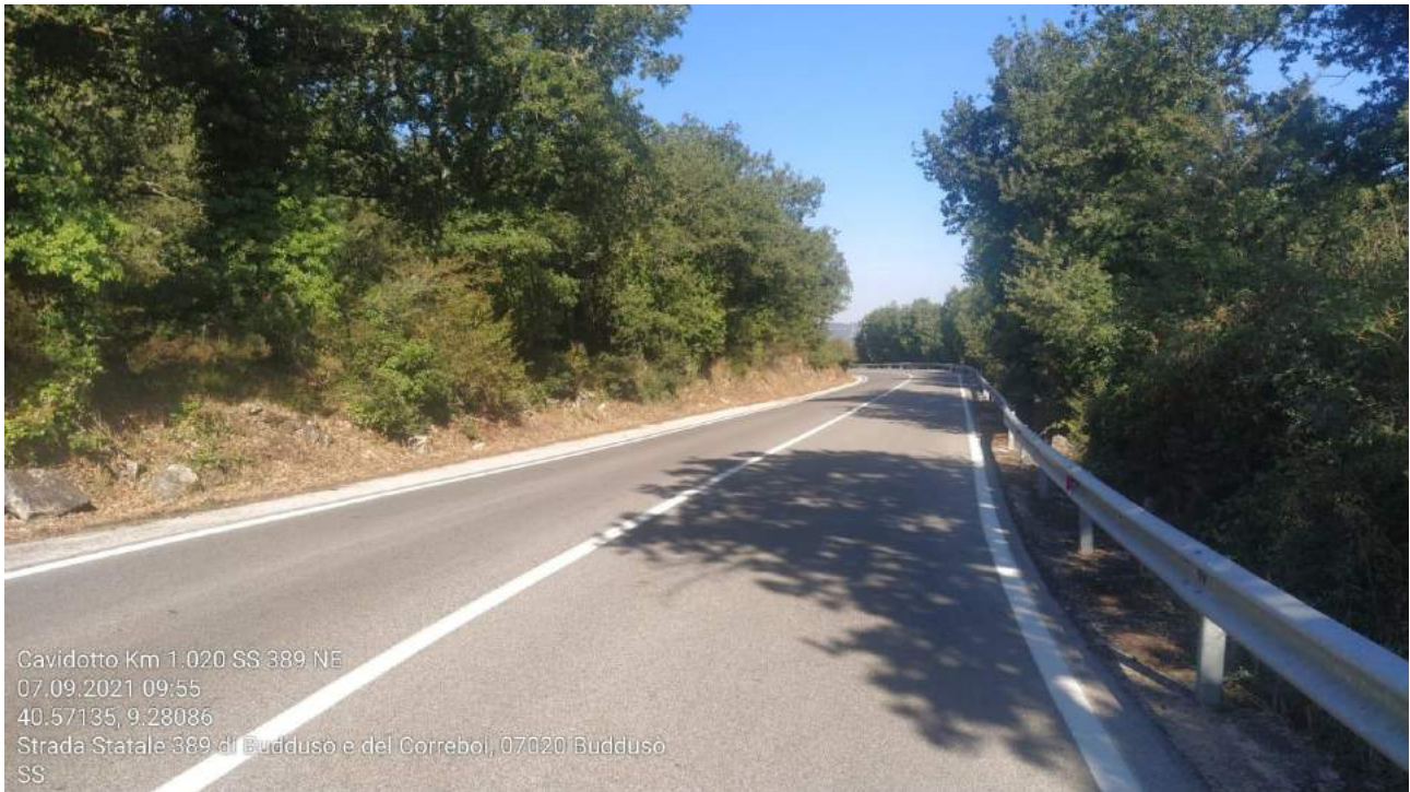
Buddusò, Strada Statale 389: tratta interessata dal tracciato del cavidotto.
