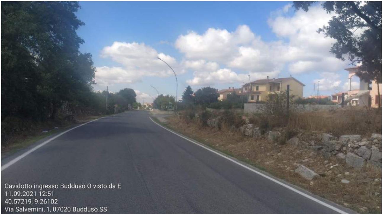
Buddusò, ingresso ovest centro abitato: strada interessata dal tracciato del cavidotto.
