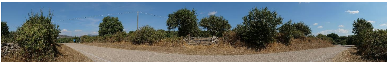
Foto post-Operam del PF110
