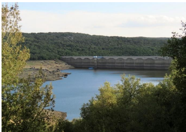
Figura 30 – Diga Sos Canales – Buddusò
