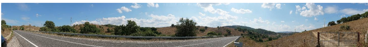
Foto post-Operam del PF83
