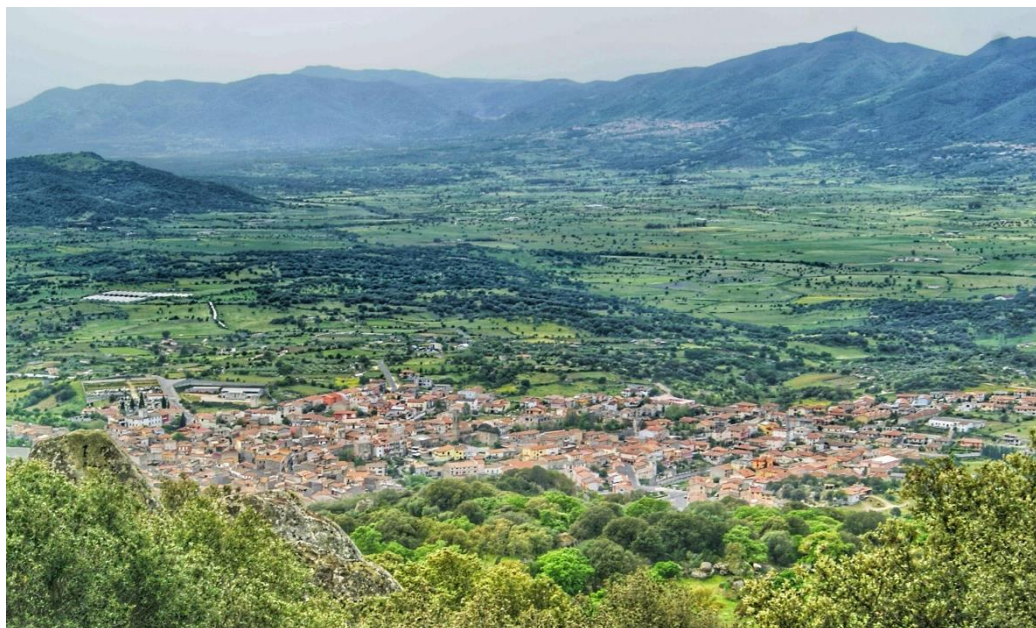
Figura 14 - Centro abitato - Comune di Benetutti (SS)
