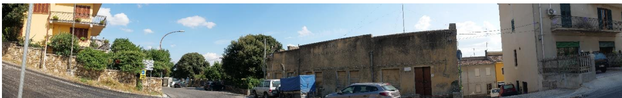
Foto post-Operam del PF8
