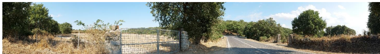
Foto post-Operam del PF18
