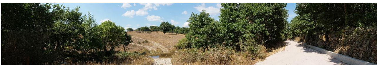
Foto post-Operam del PF186
