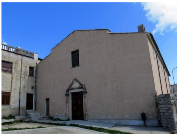
Figura 36 - Chiesa San Quirico - Esterno
