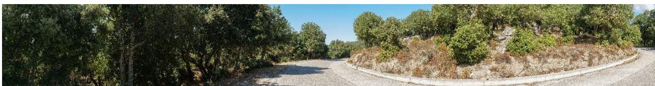
Foto Post - Operam del PF46
