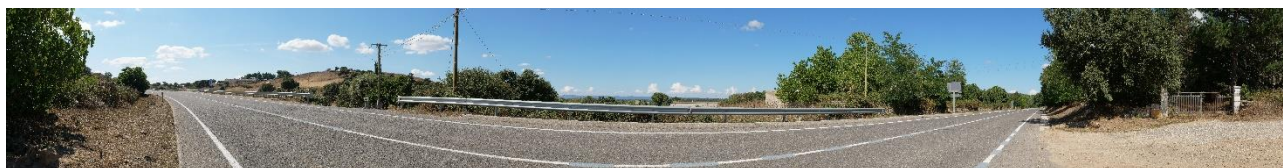
Foto Post - Operam del PF127
