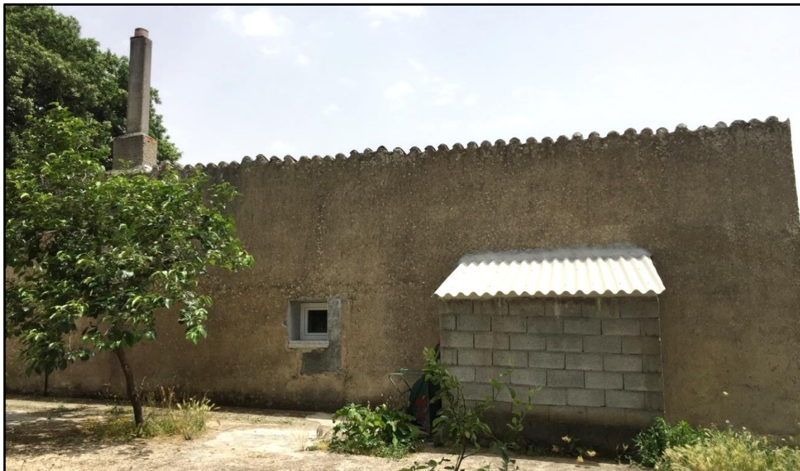
Figura 14 - Facciata Ovest dell'edificio residenziale ricettore REC 17, lato aerogeneratori
