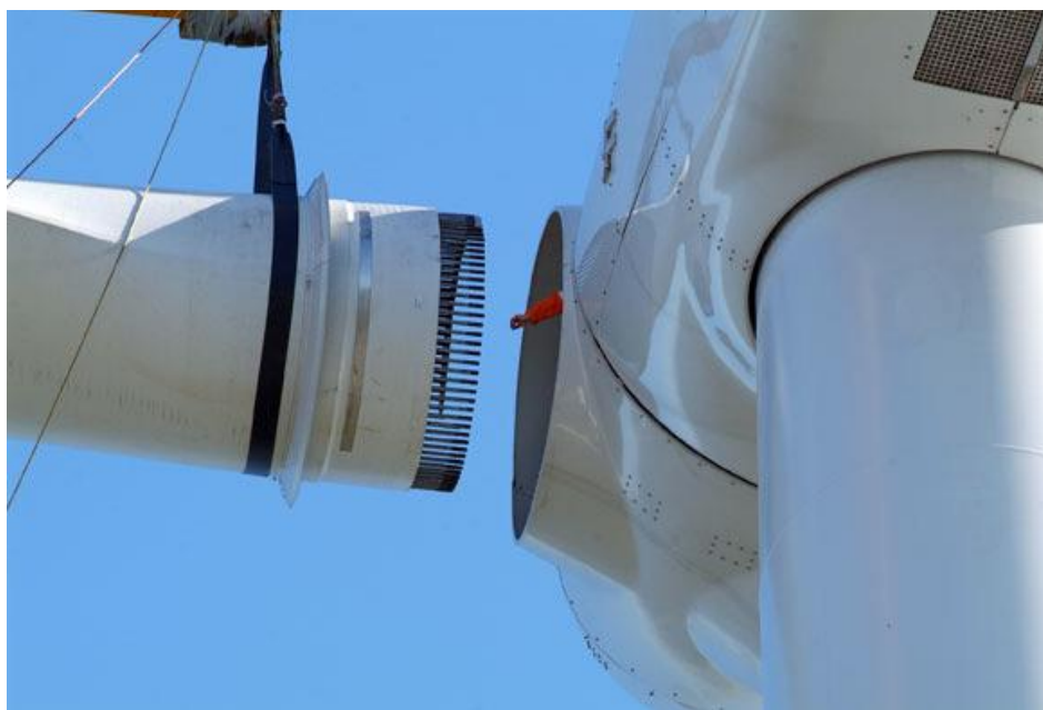
Figura 3 Collegamento pala-mozzo
