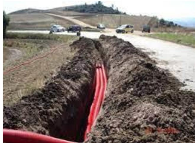
Figura 31 - Posa cavidotto MT tipo
