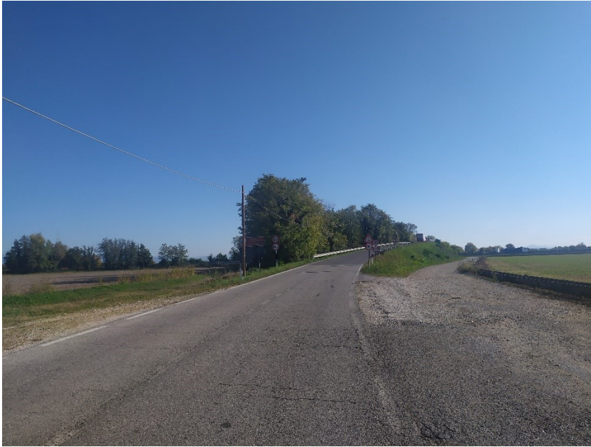
Foto 7 – Strada Provinciale 71 – innesto via Monte Nero
