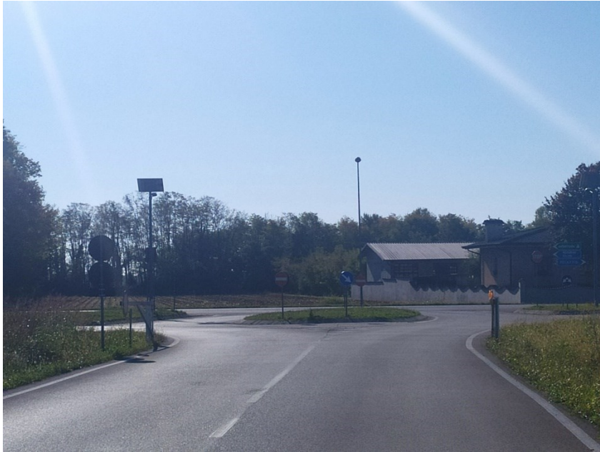
Foto 5 - Strada esistente – Incrocio con via G. Verdi
