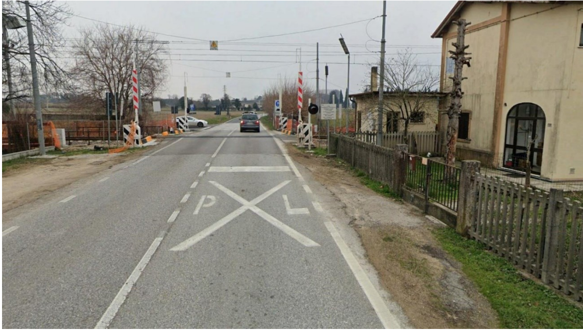
Foto 20bis – SR252 – attraversamento ferroviario
