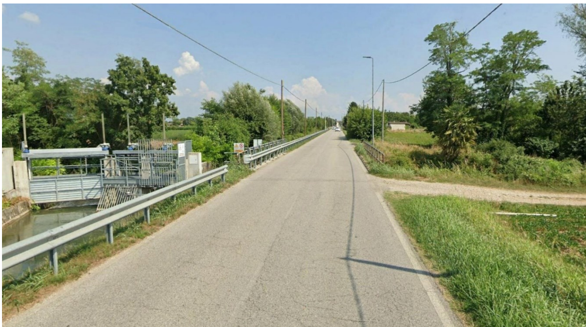
Foto 10bis - Strada Provinciale 71 – attraversamento canale – Incrocio tra la Roggia Di Palma e la Roggia Brentana
