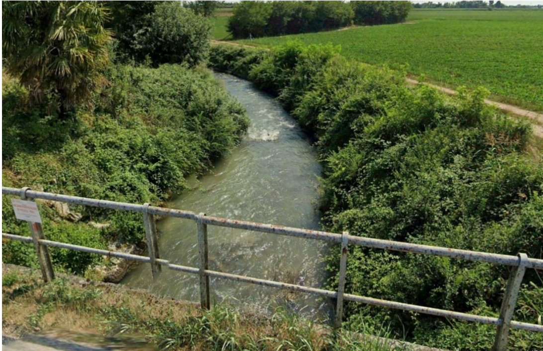
Foto 10ter - Strada Provinciale 71 – attraversamento canale – Incrocio tra la Roggia Di Palma e la Roggia Brentana
