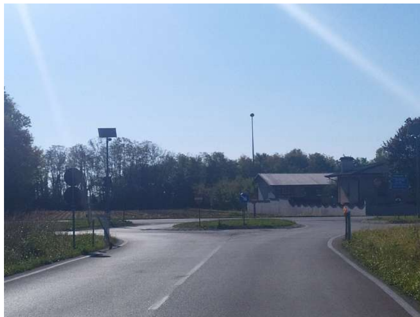
Foto 5 - Strada esistente – Incrocio con via G. Verdi
