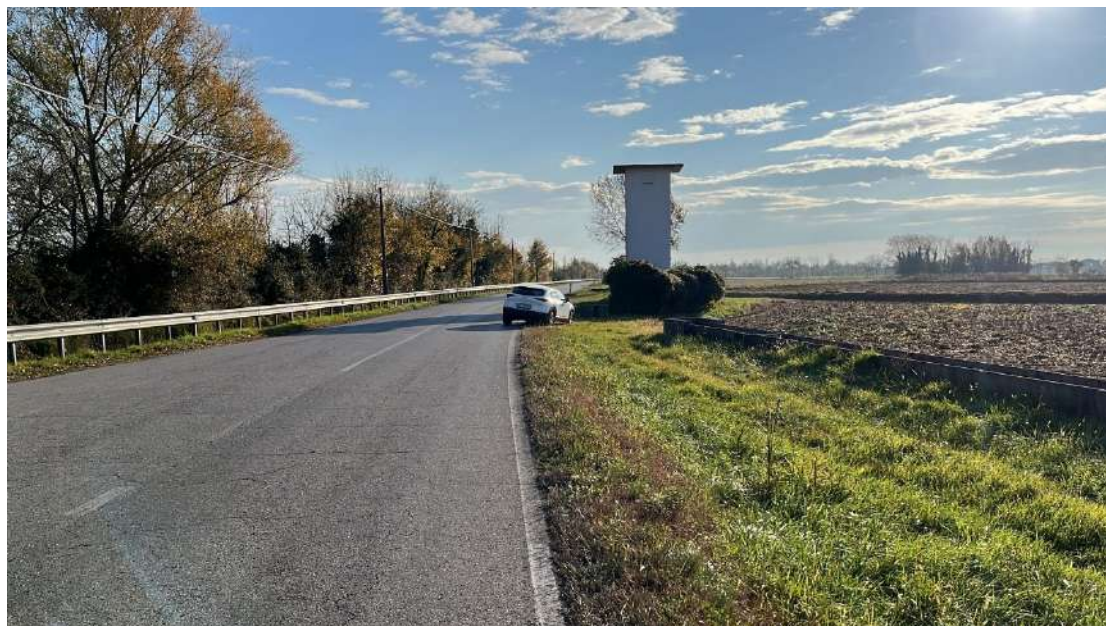
Foto 8 - Strada Provinciale 71 – Particolare attraversamento tombino stradale
