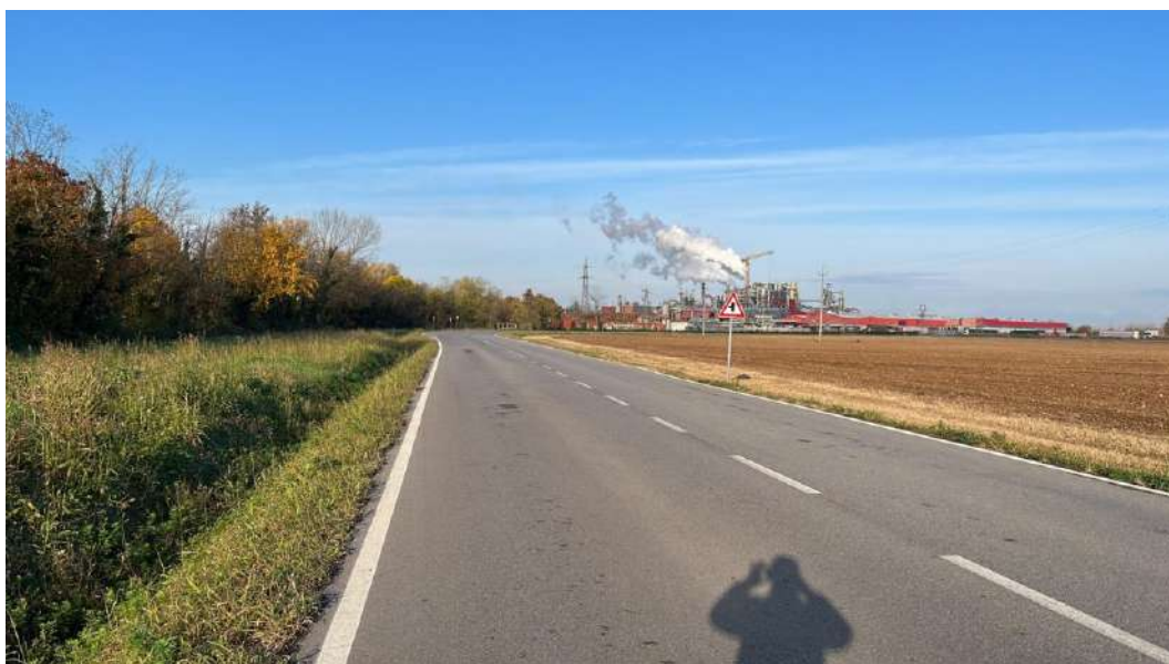
Particolare del complesso industriale nelle vicinanze dell'area oggetto d'intervento
