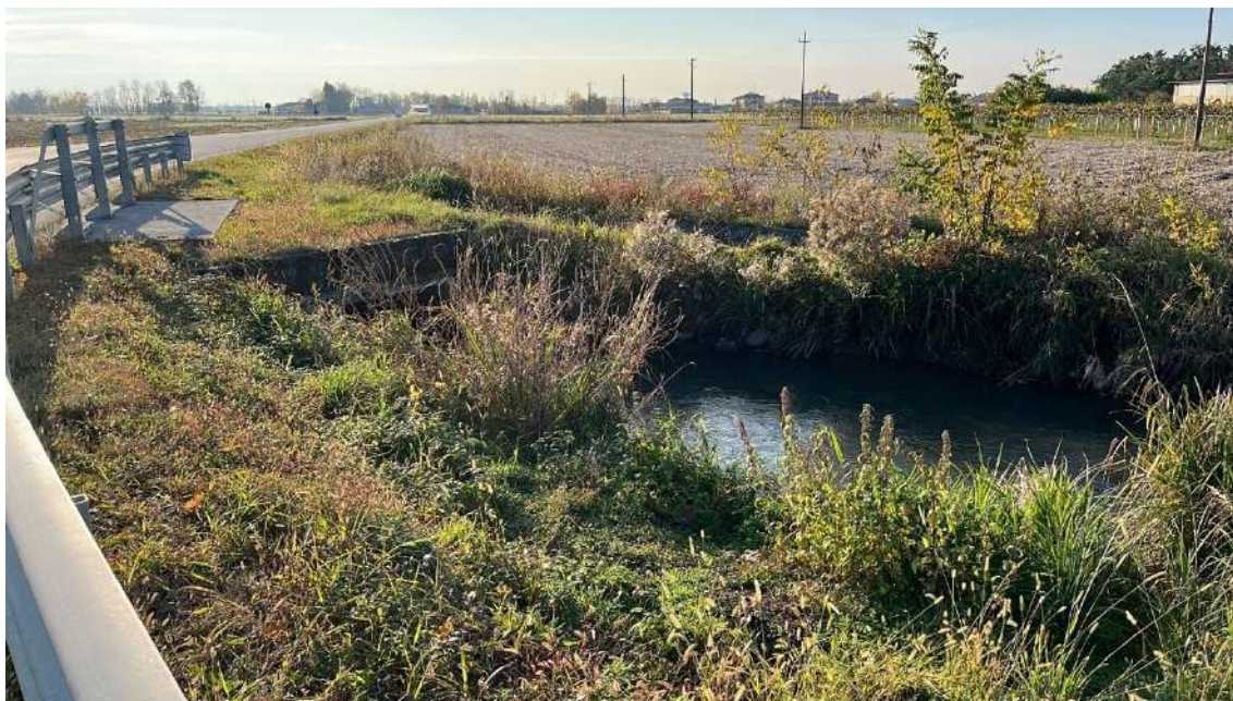
Foto 2 – Particolare – Attraversamento Roggia Palmanova
