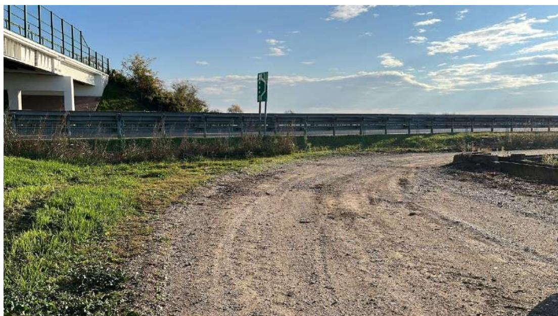
Foto 7 bis – Particola attraversamento autostradale A23
