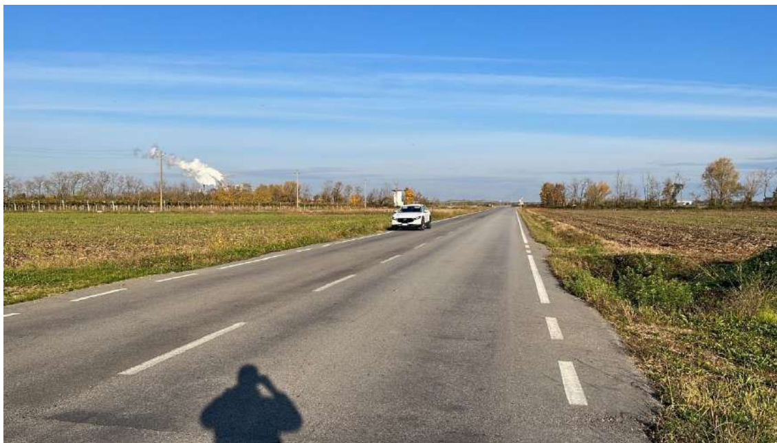
Foto 3bis – Attraversamento tombino stradale
