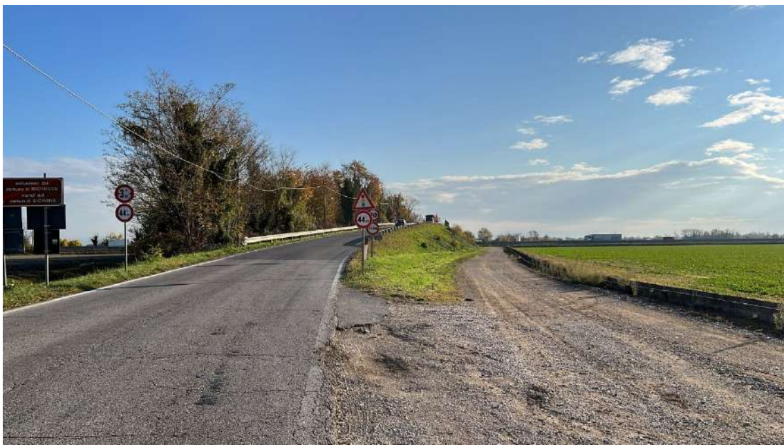
Foto 7 – Strada Provinciale 71 – innesto via Monte Nero
