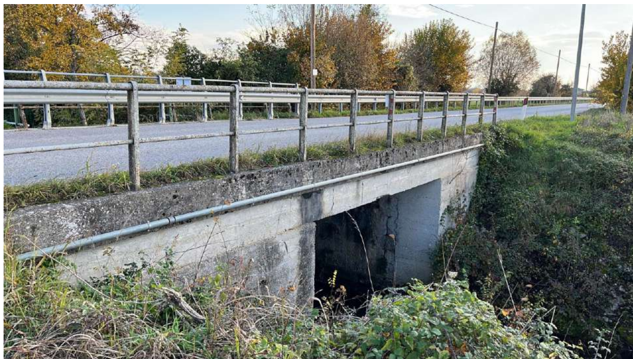
Foto 10ter - Strada Provinciale 71 – attraversamento canale – Incrocio tra la Roggia Di Palma e la Roggia Brentana
