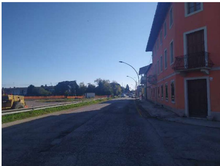
Foto 14 - Strada Provinciale 71 – Viale San Marco
