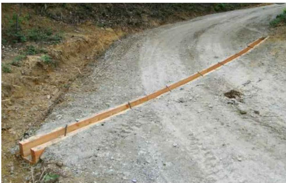
Figura 37: Opere di regimentazione idraulica – rompiflusso in legno
